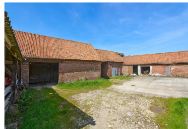
Vue de la grange et d'une partie des porcheries depuis le sud-ouest. Phot. Thierry Lefébure IVR32_20236200573NUCA
