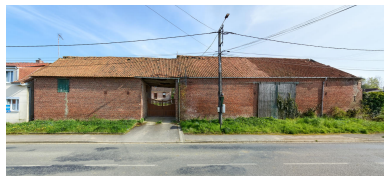
Vue générale depuis la rue. Phot. Thierry Lefébure IVR32_20236200570NUCA
