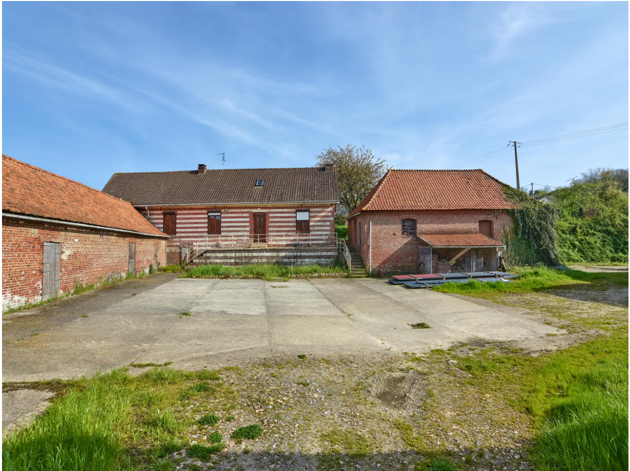
Vue générale depuis la cour du logis.
