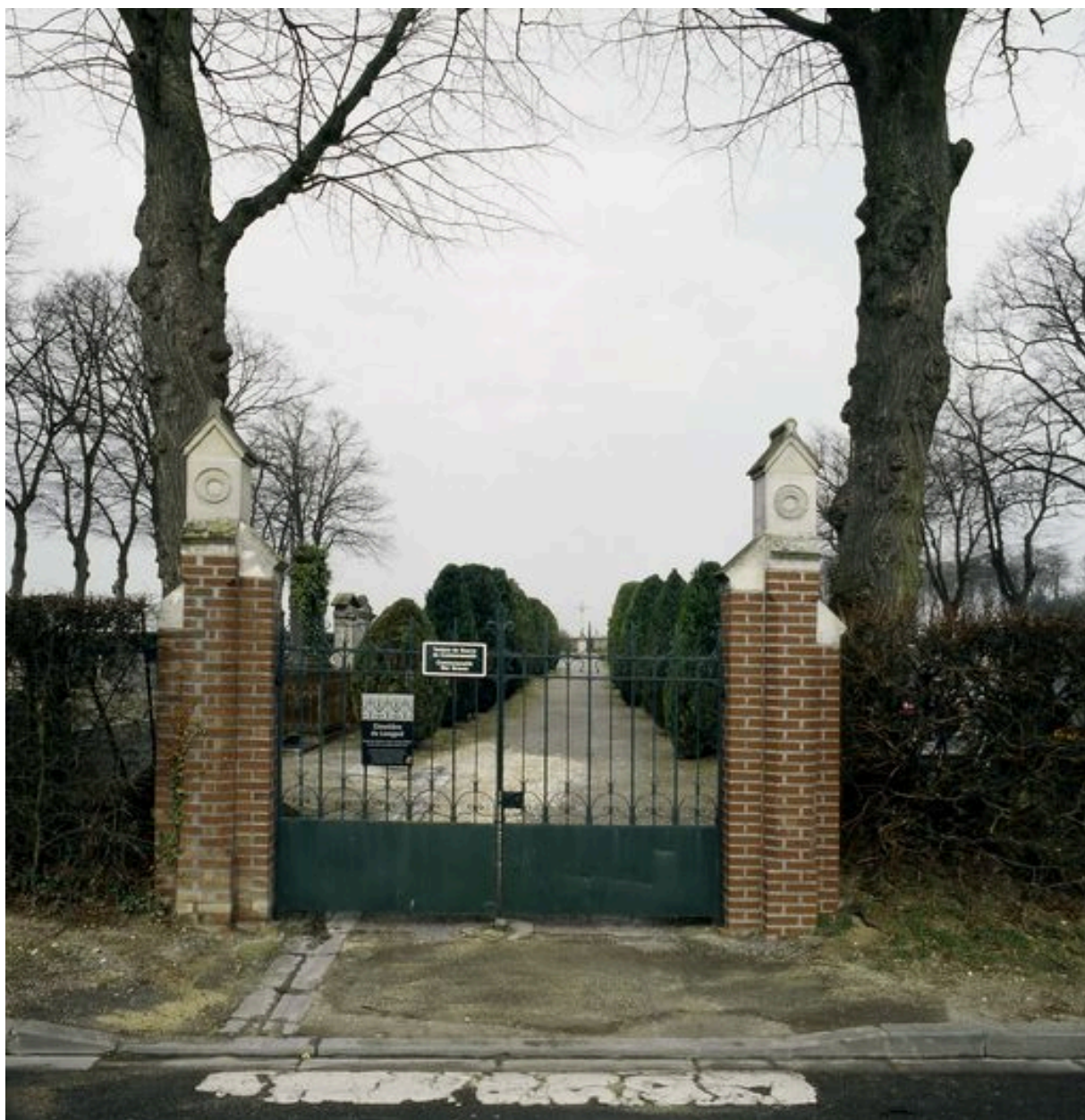
Vue générale, depuis la rue Saint-Léger.
