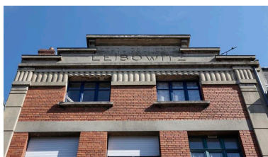
Ensemble Art déco constitué par le fronton géométrique et la frise aux motifs tubulaires. Phot. Pierre Thibaut IVR31_20096200210NUCA
