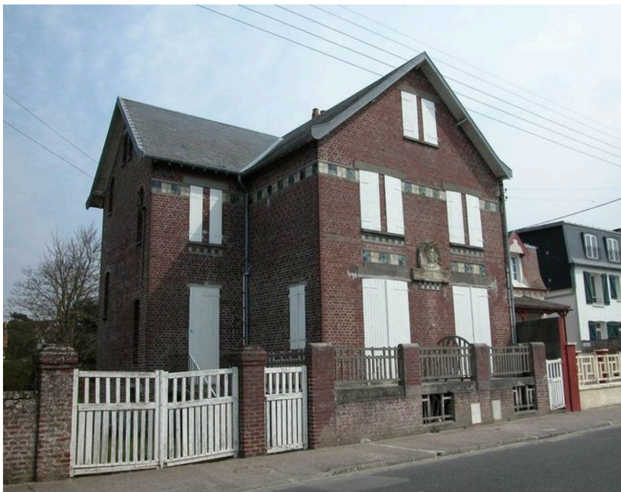
Vue d'ensemble depuis la rue Guy-Dath.
