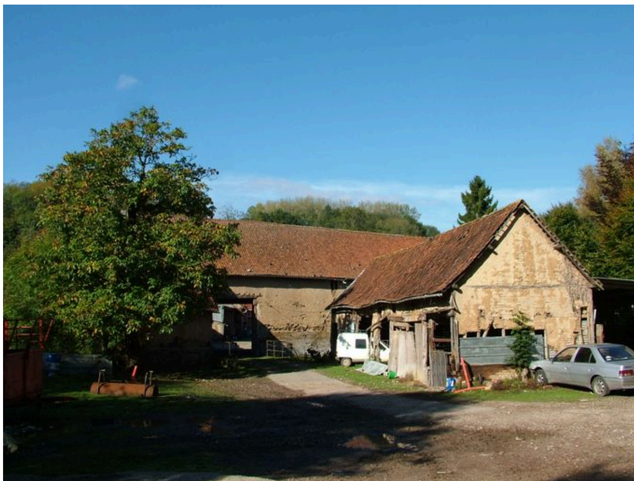
Vue des granges depuis la cour arrière.
