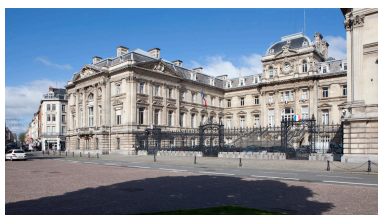
Vue générale de la façade côté rue. Phot. Pierre Thibaut IVR31_20135901305NUCA
