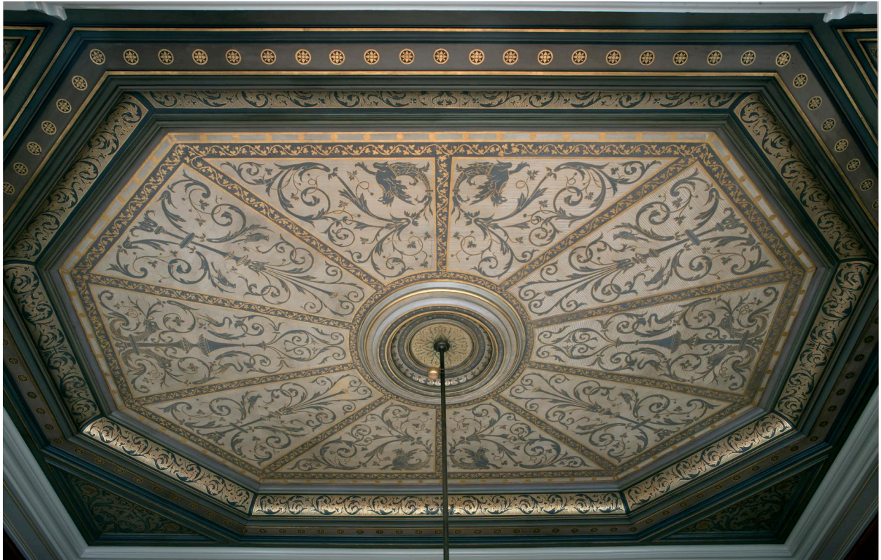
Le bureau du Préfet : plafond à caisson.
