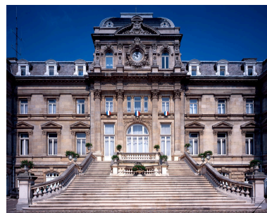
Façade principale donnant sur la place de la République, élévation du bâtiment fermant le fond de la cour d'honneur, vue générale. Phot. Pierre Thibaut IVR31_20005901681VA
