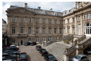
Cour d'honneur. Phot. Pierre Thibaut IVR31_20135901330NUCA
