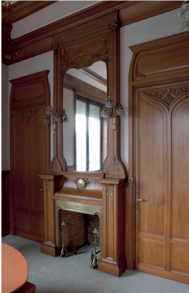
1er étage, locaux des services de la préfecture, bureau du secrétariat du préfet, élévation intérieure du côté de la cheminée, vue générale.
