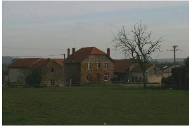
Vue générale. Phot. Inès Guérin IVR22_20030202899NUCA
