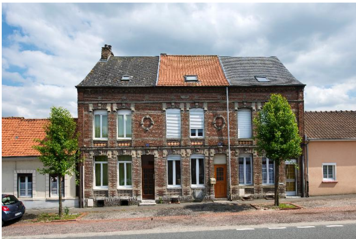
Vue d'ensemble des trois logements.
