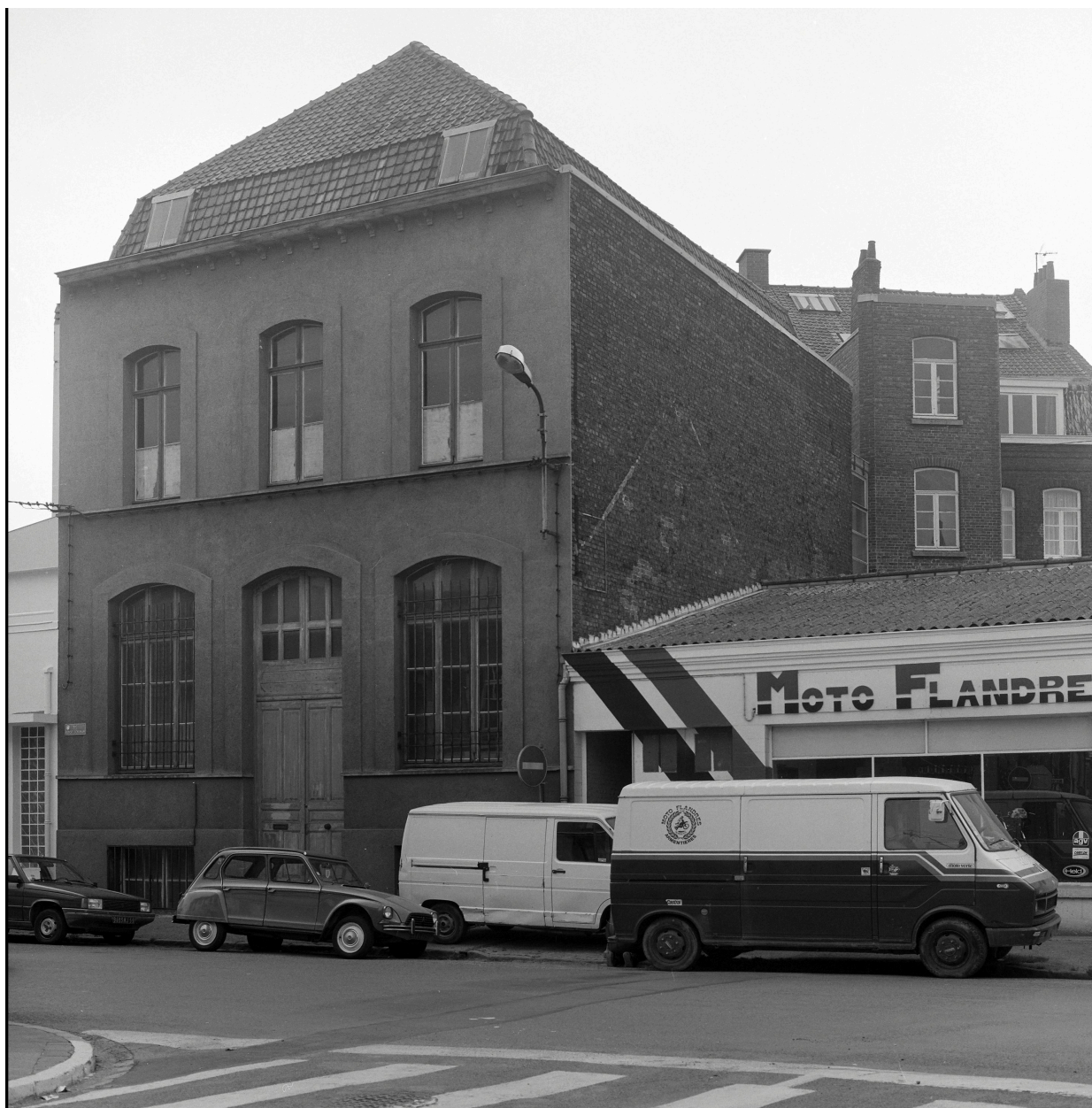
Élévation postérieure, rue Robert Schuman.
