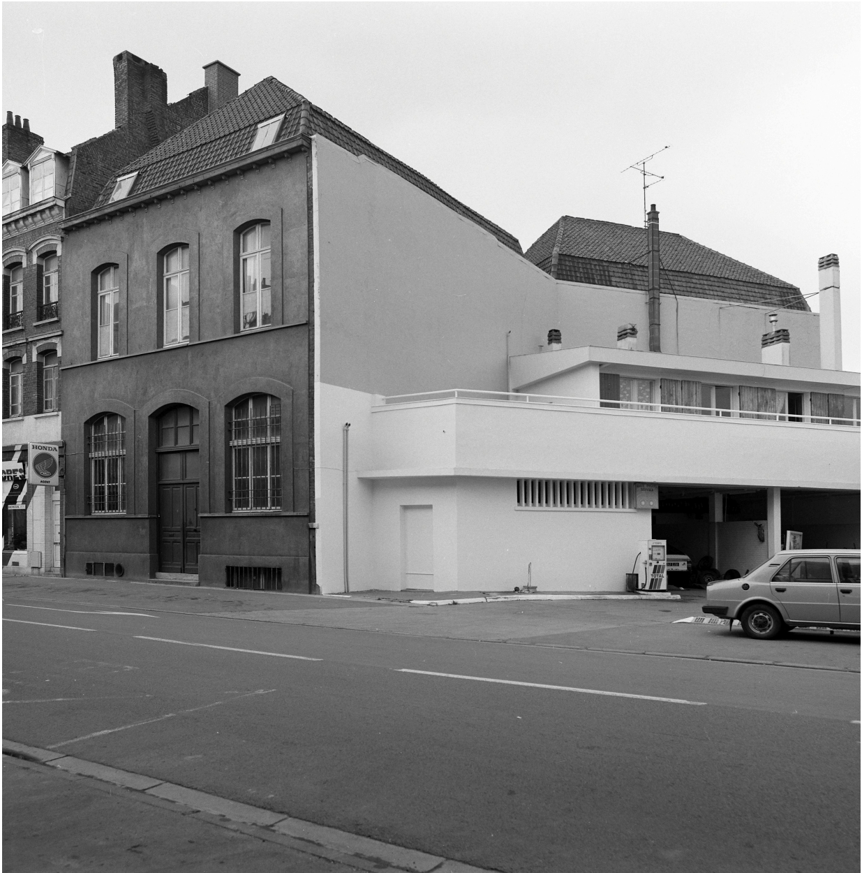
Élévation antérieure, rue de la Gare.
