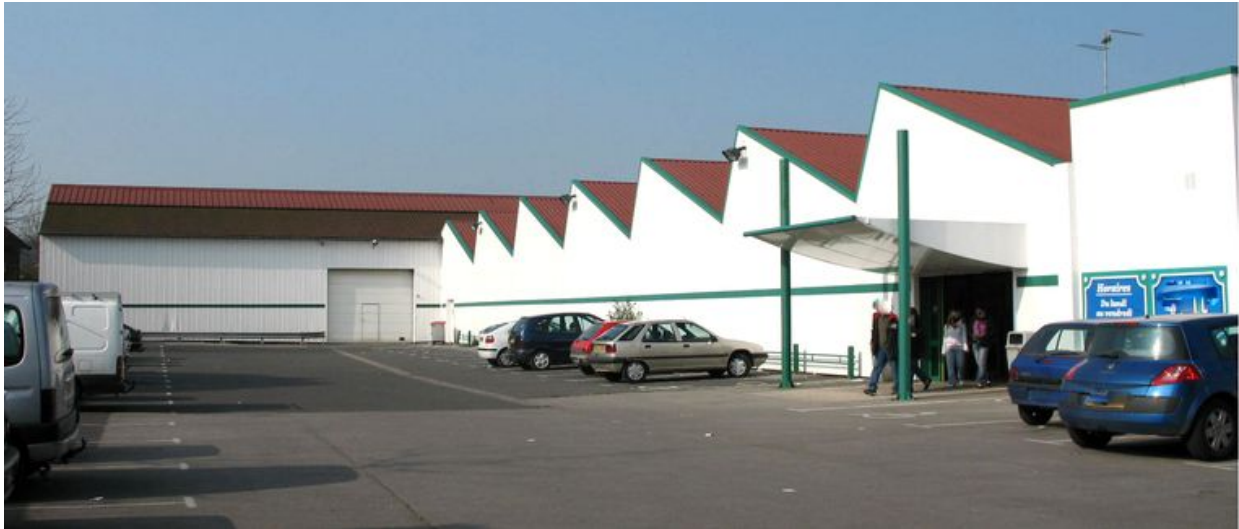
Vue générale de l'usine, façade ouest.
