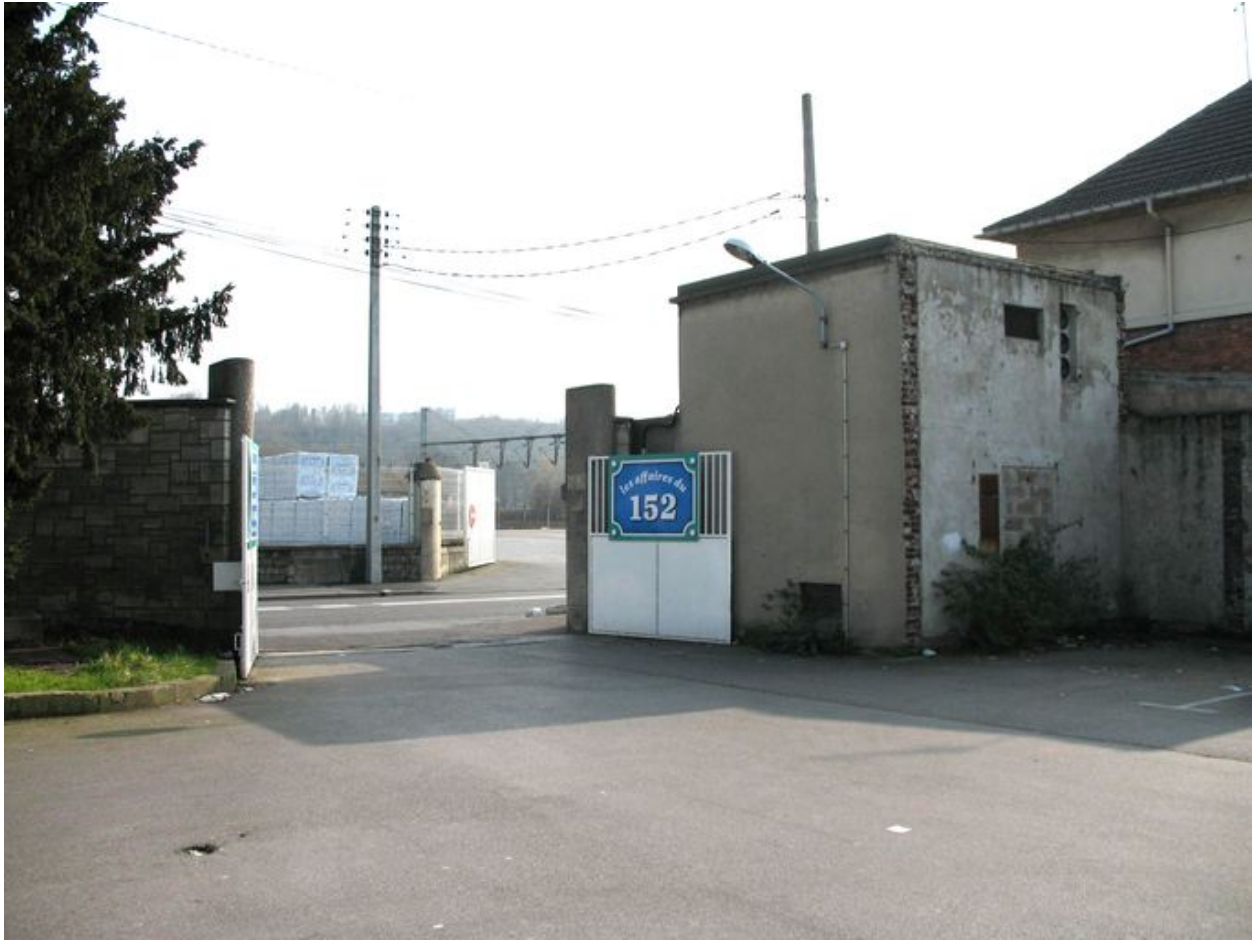
Entrée de l'usine et transformateur électrique.
