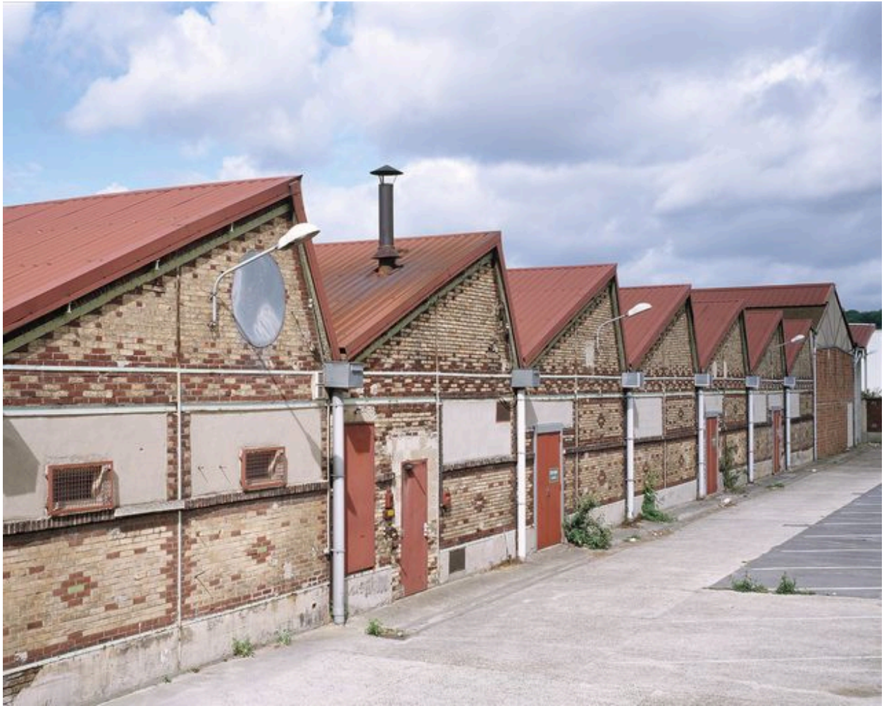
Façade est de l'usine : enfilade de sheds.
