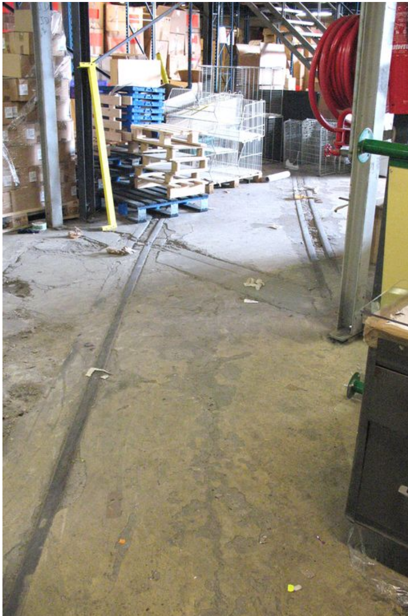
Vestiges des rails dans l'entrepôt.
