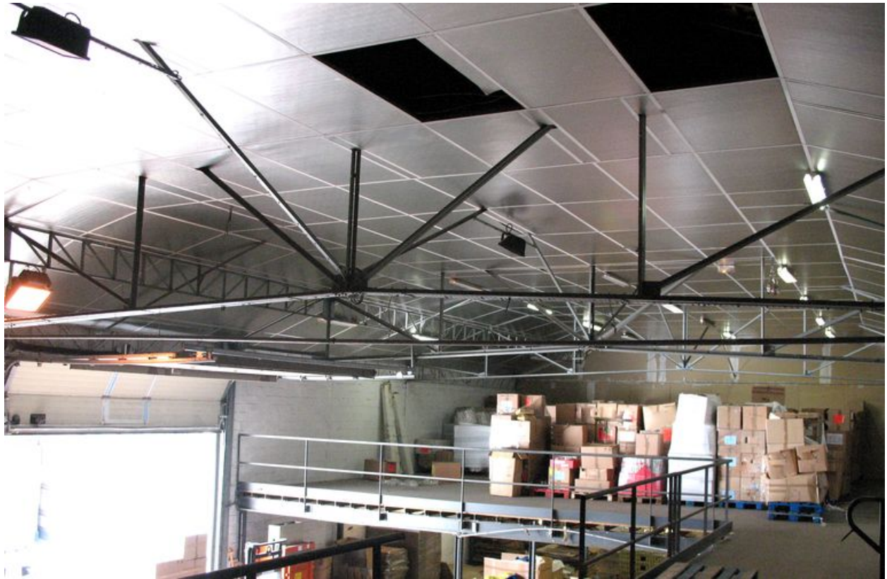
Charpente métallique de l'entrepôt.
