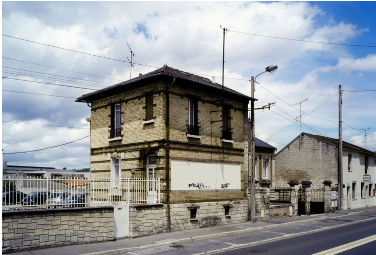
Bâtiment administratif et logement de l'usine.
