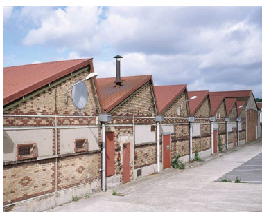
Façade est de l'usine : enfilade de sheds. Phot. Thierry Lefébure IVR22_20076000067XA
