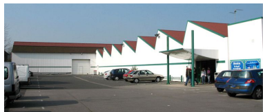
Vue générale de l'usine, façade ouest. Phot. Clarisse Lorieux IVR22_20076005098NUCA
