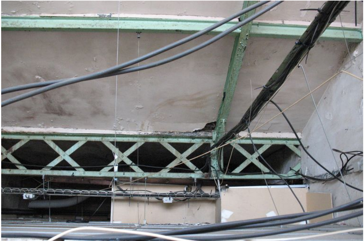
Détail d'une poutrelle métallique sous les sheds.
