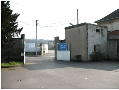
Entrée de l'usine et transformateur électrique. Phot. Clarisse Lorieux IVR22_20076005114NUCA
