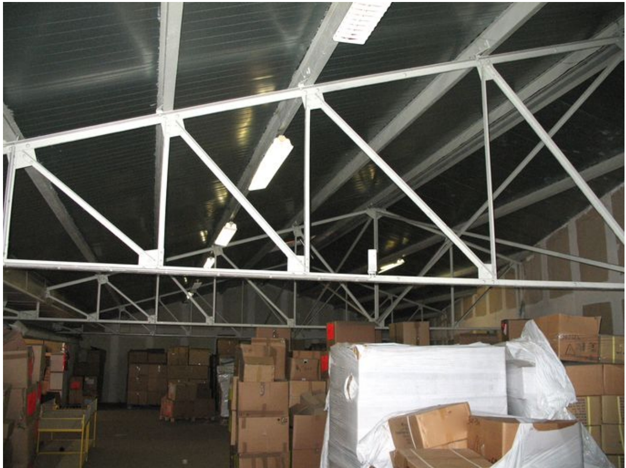
Charpente de l'un des entrepôts.
