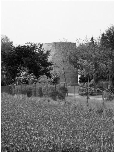
Le moulin Arrachard. Phot. Judith Förstel IVR22_20018000284Z
