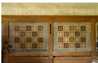
Détail des lambris avec fente pour surveiller les chevaux. Phot. Marc Kérignard IVR32_20246000757NUCA
