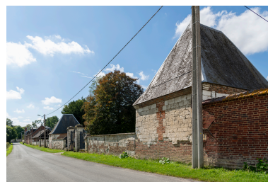
Pavillons et mur de clôture alignés sur la rue, vue depuis le nord-est. Phot. Marc Kérignard IVR32_20246000887NUCA
