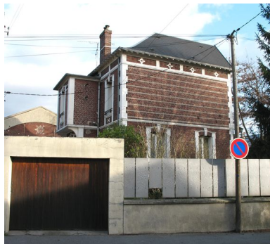
L'ancien logement patronal depuis la rue Jean-de-La-Fontaine. Phot. Clarisse Lorieux IVR22_20066005080NUCA
