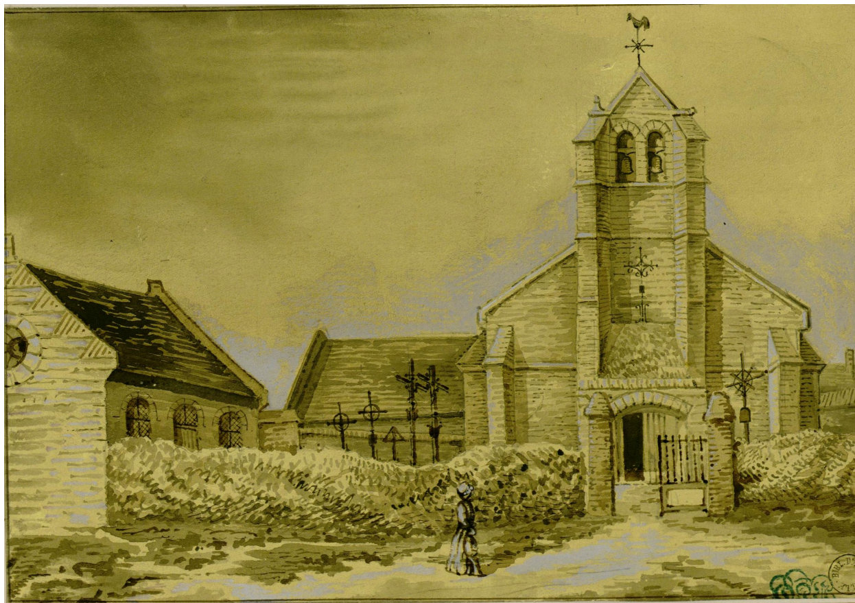
Église d'Épagne, canton d'Abbeville, par Oswald Macqueron, [s.d.] (Archives et Bibliothèque patrimoniale d'Abbeville ; Ab.M28).
