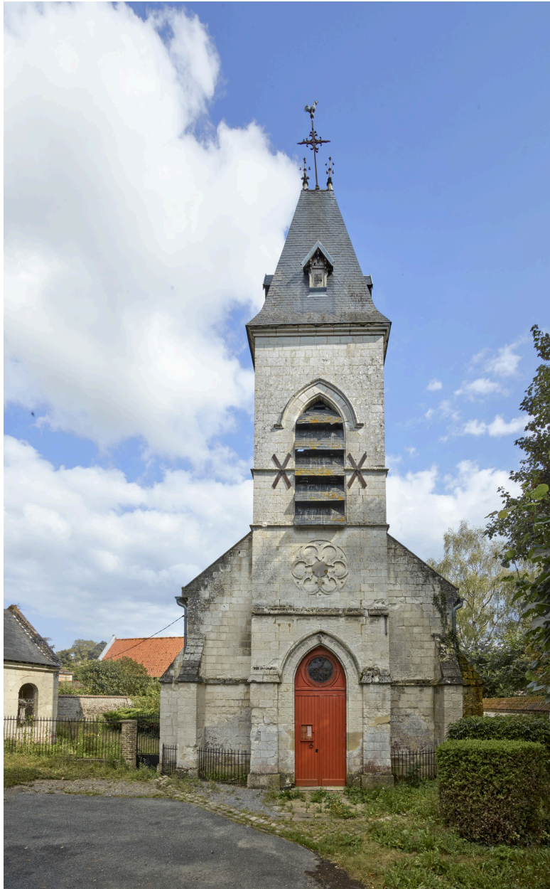
Vue du clocher-porche, depuis l'ouest.
