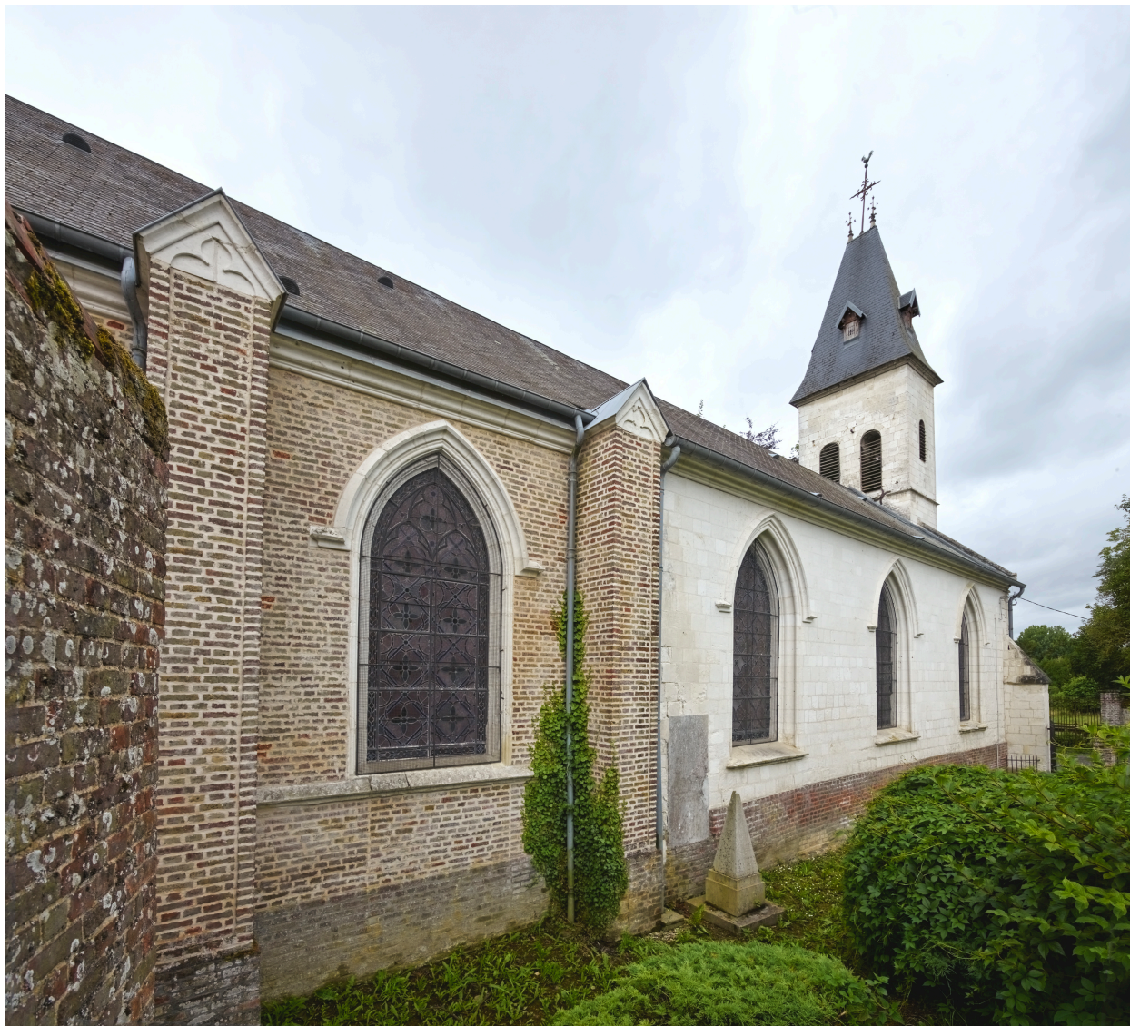
Vue de l'église, depuis le nord-ouest.
