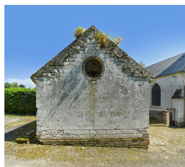
Vue du mur-pignon ouest de la chapelle funéraire. Phot. Thierry Lefébure IVR32_20248001349NUCA
