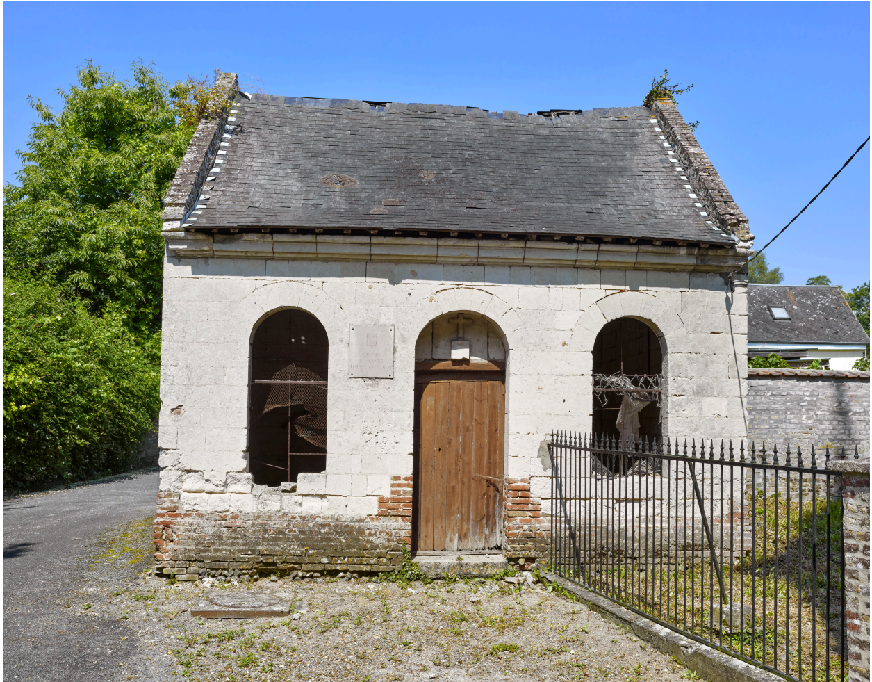
Vue de la chapelle funéraire, depuis le sud.
