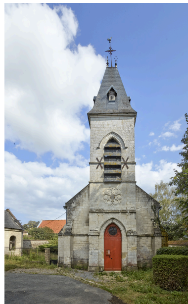
Vue du clocher-porche, depuis l'ouest. Phot. Thierry Lefébure IVR32_20248001360NUCA
