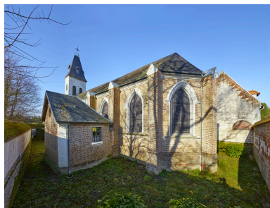
Vue du chevet et de la sacristie, depuis le sud-est. Phot. Thierry Lefébure IVR32_20258000231NUCA
