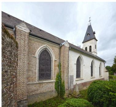
Vue de l'église, depuis le nord-ouest. Phot. Thierry Lefébure IVR32_20248001359NUCA
