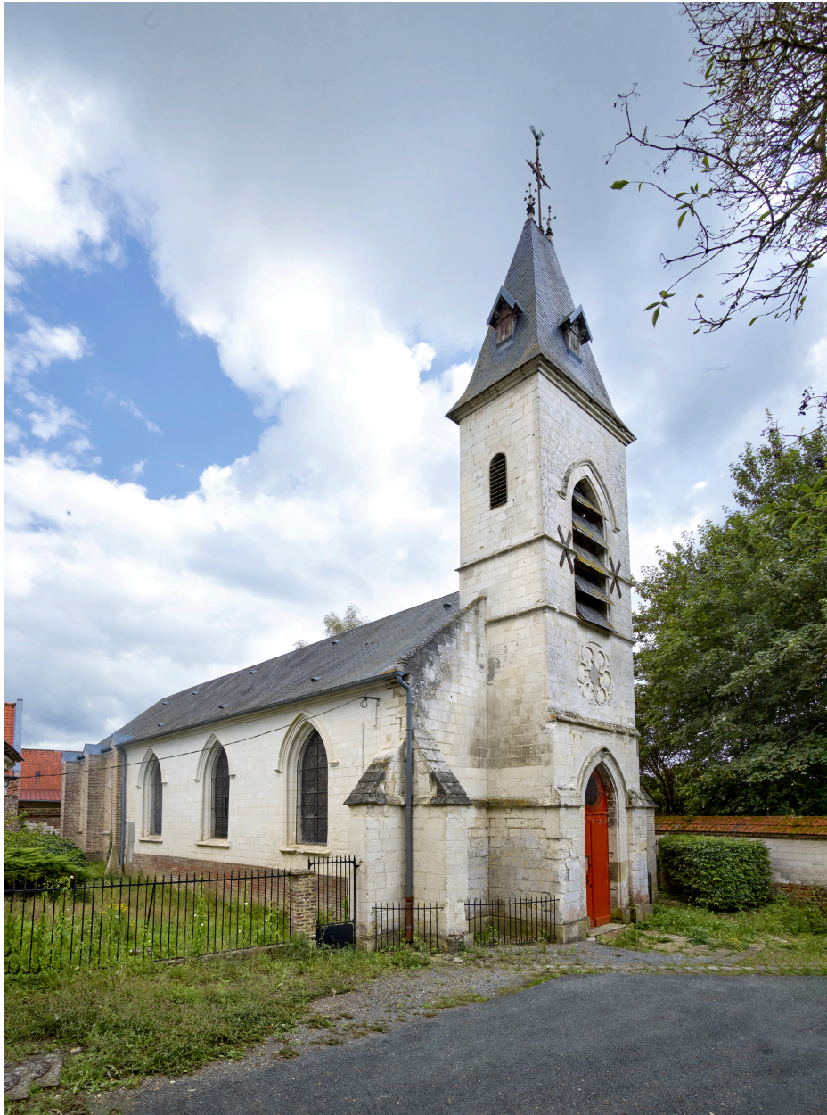
Vue d'ensemble de l'église depuis le nord-ouest.
