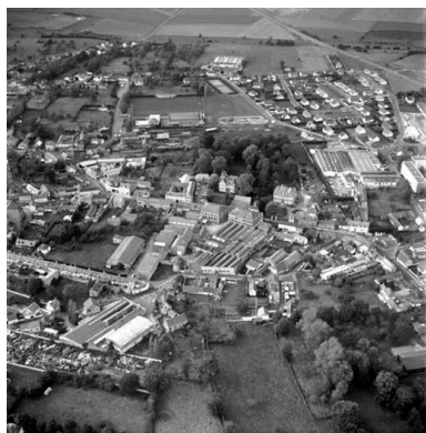
Vue aérienne nord de l'agglomération.
