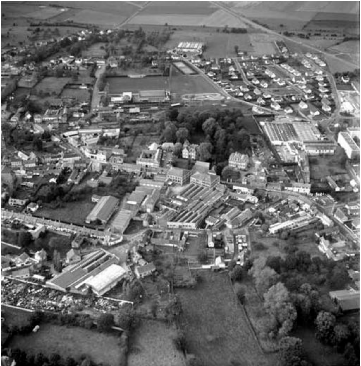
Vue aérienne nord de l'agglomération.
