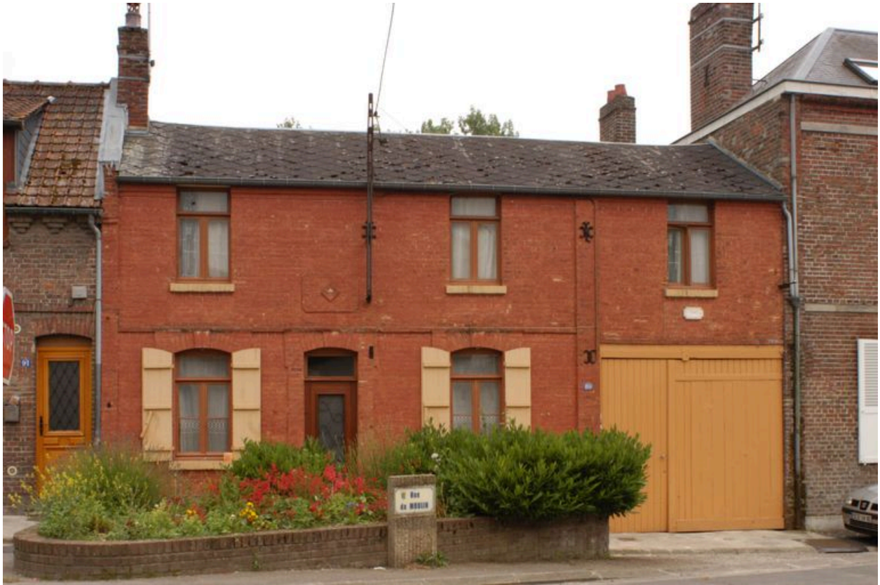
Vue de situation, maison au premier plan.
