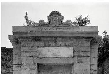
Détail, motif sculpté de la corniche. Phot. Jean-Michel Périn IVR31_19806203986X
