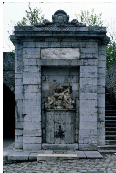
Elévation rue d'Aumont. Phot. Éric Dessert, Phot. Jean-Michel Périn IVR31_19836200093ZA
