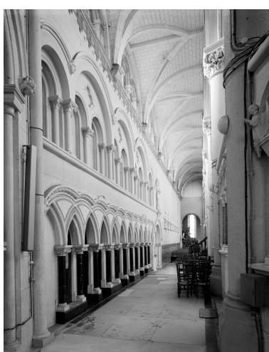
Vue d'ensemble du déambulatoire. Phot. Philippe Dapvril IVR22_19956200171V
