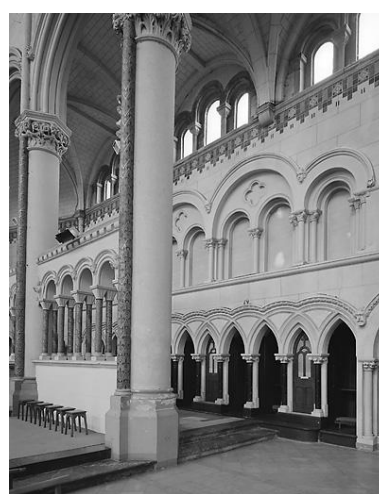
Vue d'ensemble de la nef. Phot. Philippe Dapvril IVR22_19956200169V
