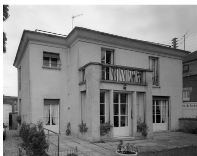
Elévation postérieure. Phot. Fabrice Charrondière IVR22_19856001432V
