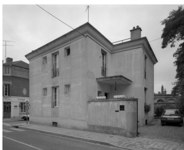
Elévation sur rue. Phot. Fabrice Charrondière IVR22_19856001431V
