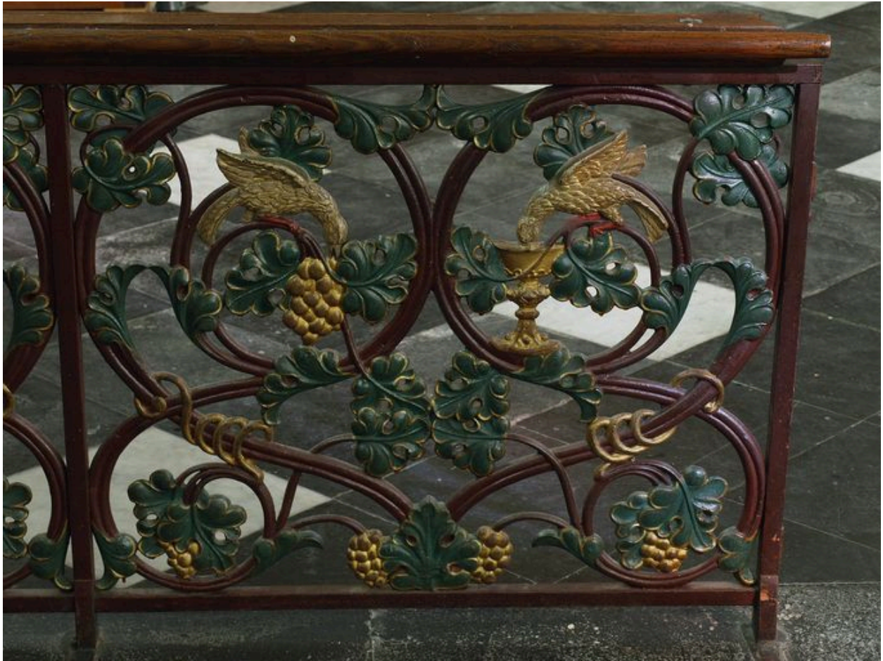
Clôture nord : détail des motifs
