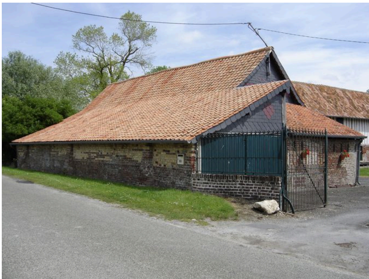
Vue postérieure depuis la cour.
