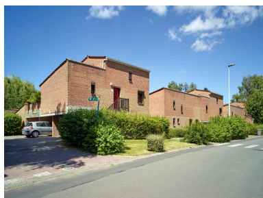
Vue depuis la rue Charles-le-Bon, au niveau du Chemin du Change.
