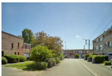
Depuis le nord de la rue Jeanne-d'Arc : d'une rive à l'autre formes, gabarit, matériaux sont similaires.
