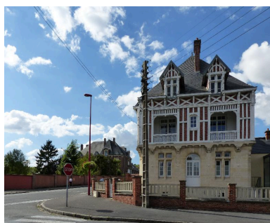
Vue depuis le sud.
