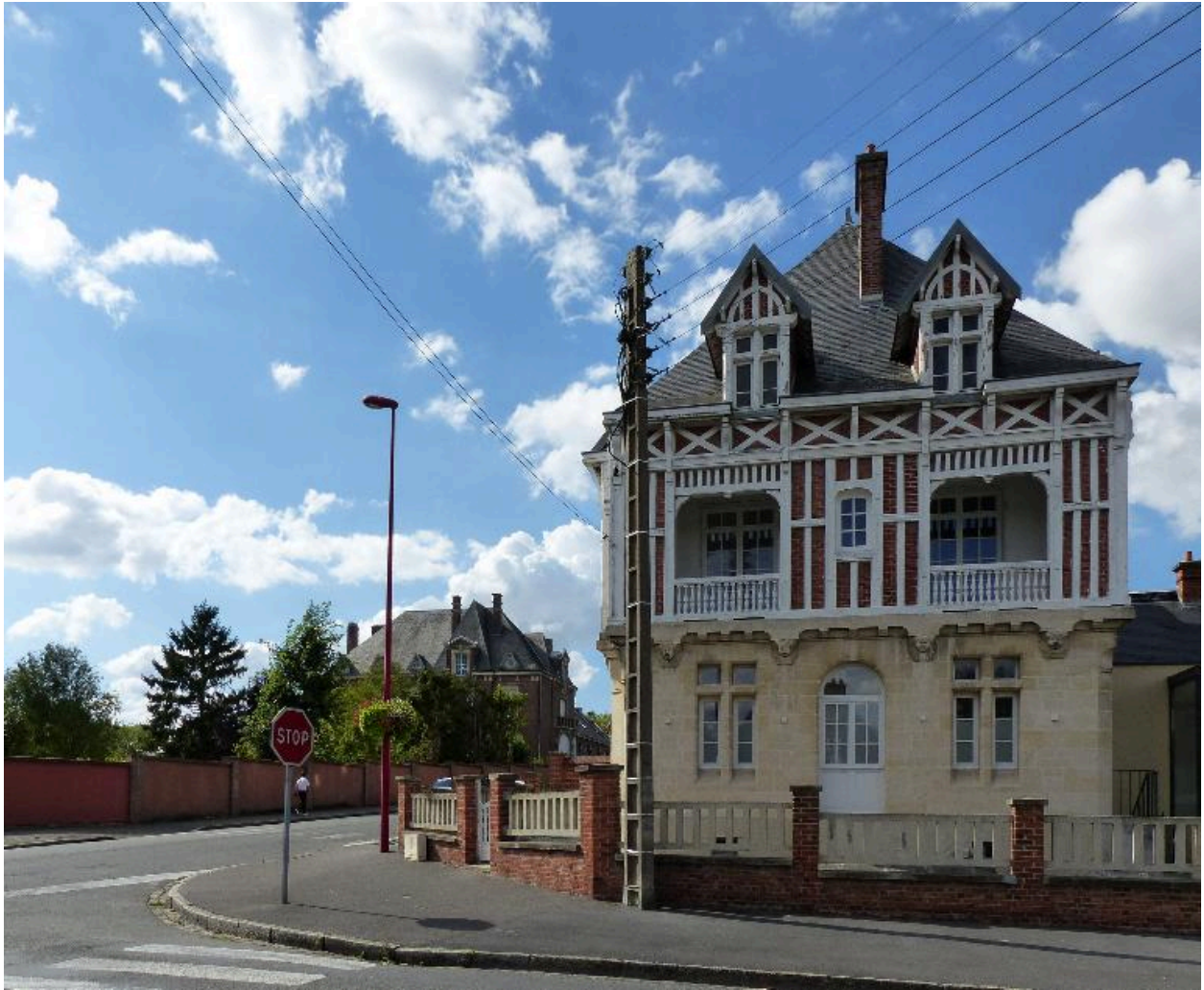
Vue depuis le sud.
