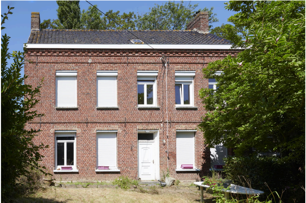
Façade principale (sud) du presbytère.
