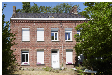
Façade principale (sud) du presbytère. Phot. Delphine Volto Jourdan IVR32_20245902750NUCA
