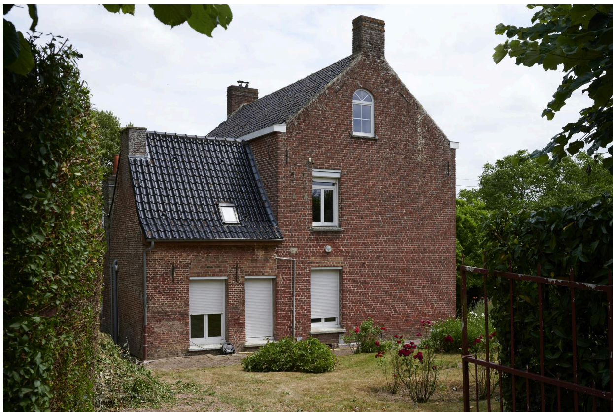
Pignon sud-ouest et annexe.
