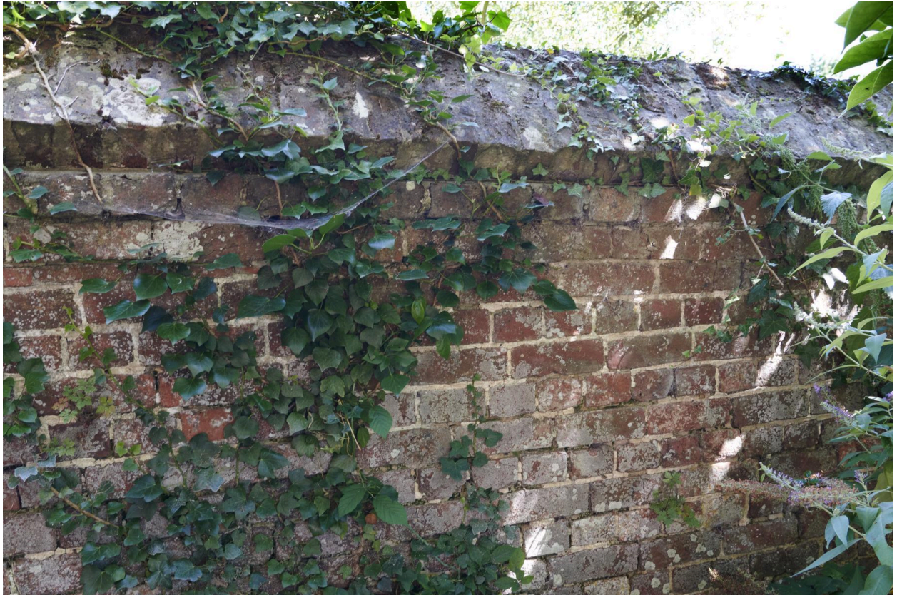
Vestige du mur de clôture en brique du presbytère.
