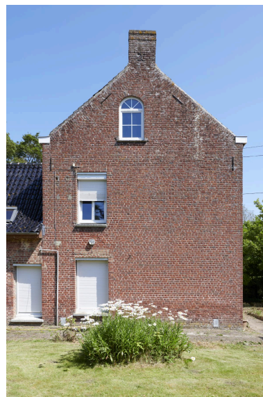
Détail du pignon ouest. Phot. Delphine Volto Jourdan IVR32_20245902747NUCA
