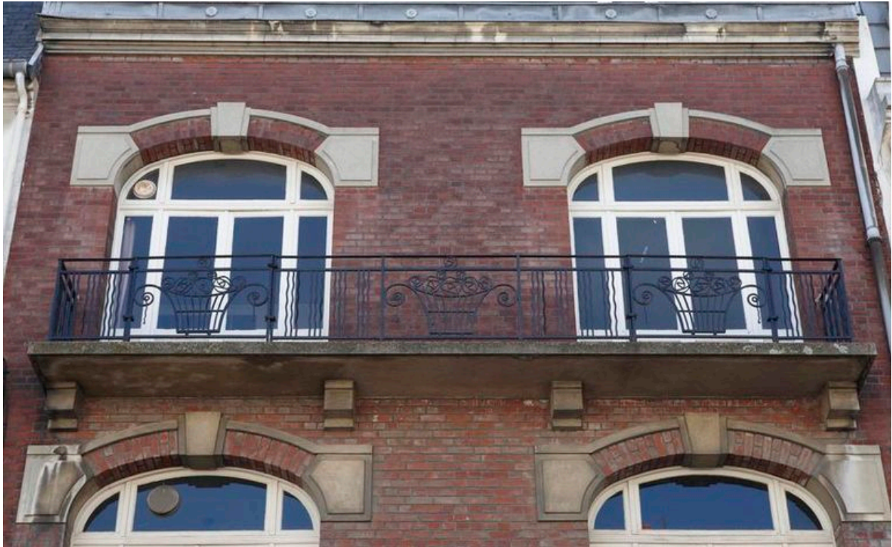
Vue sur le balcon en fer forgé du second étage, constitué de paniers à spirales et de vagues.
