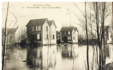
Les logements de contremaître inondés lors de la crue du Thérain en 1910 (archives d'entreprise).
