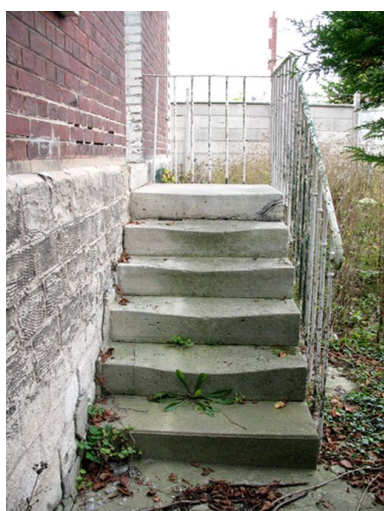
Escalier d'accès au logement d'un contremaître.
