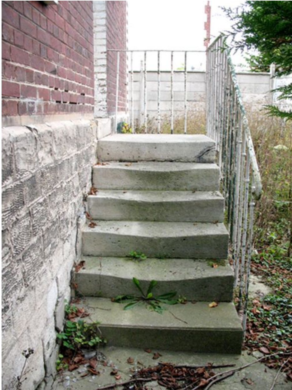
Escalier d'accès au logement d'un contremaître.
