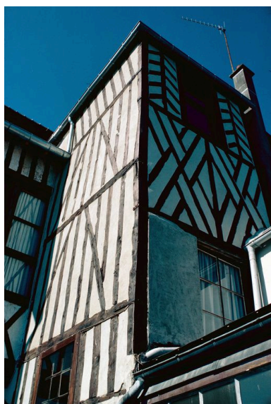
Elévation postérieure : détail de l'escalier hors-oeuvre. Phot. Martine Plouvier IVR22_19856001336ZA
