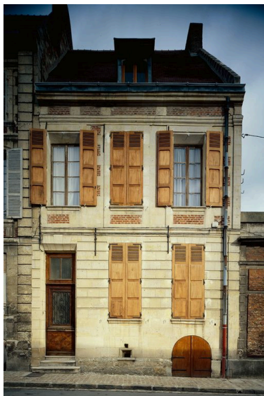
Elévation antérieure. Phot. Fabrice Charrondière IVR22_19856001476VA
