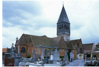
Elévation nord et le chœur. Phot. Pierre Thibaut IVR31_20085901061XA
