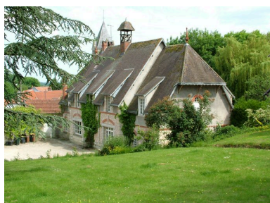
Vue des dépendances à l'entrée de la propriété. Phot. Inès Guérin IVR22_20030202634NUCA
