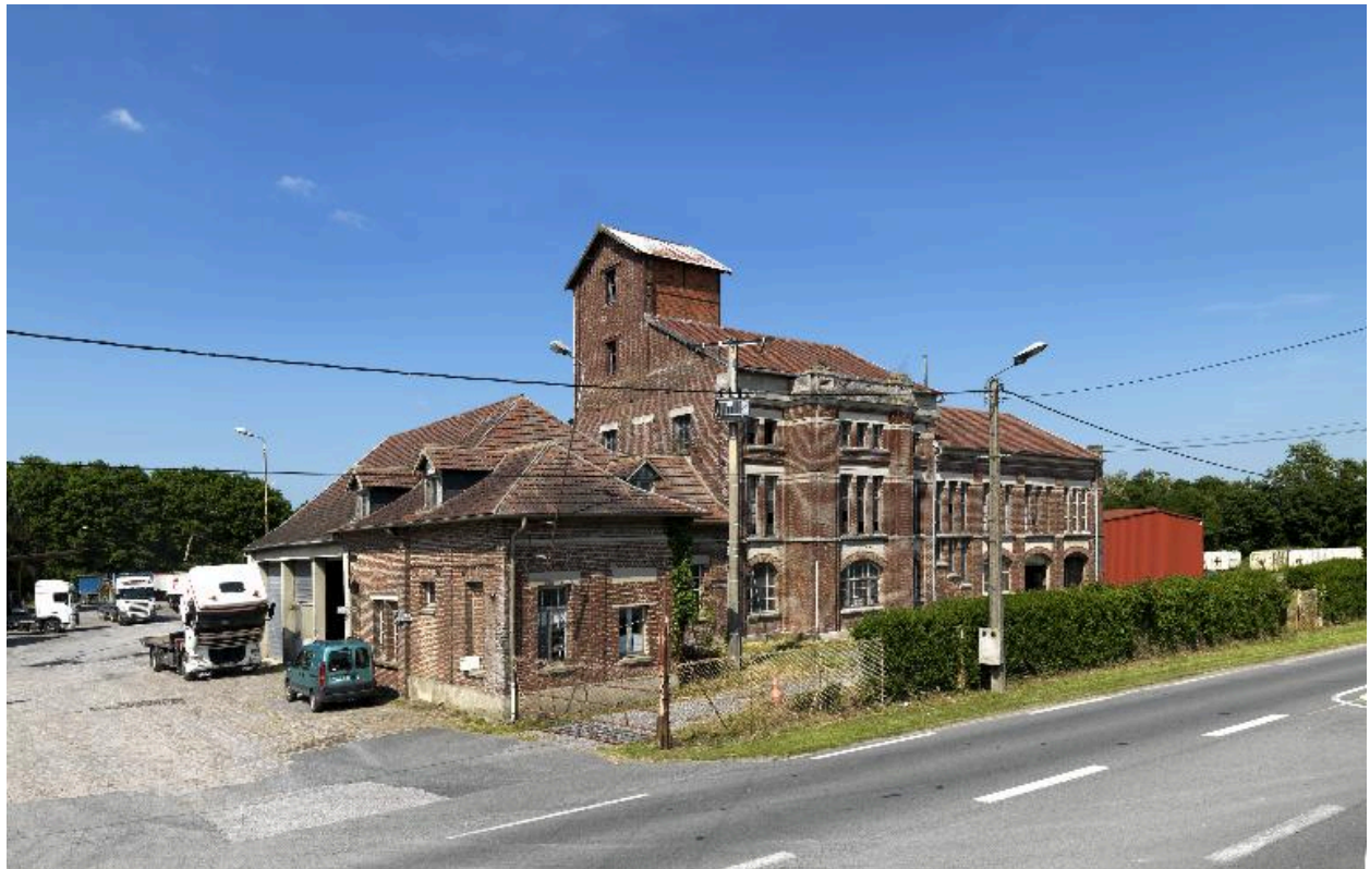
Vue d'ensemble de trois-quarts de la râperie.
