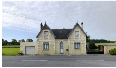
Logement dépendant de la râperie. Phot. Thierry Lefébure IVR22_20158000512NUC2A
