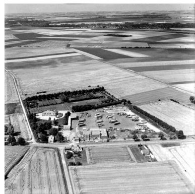
Vue aérienne, flanc sud. Phot. Phot'R IVR22_19888001323P
