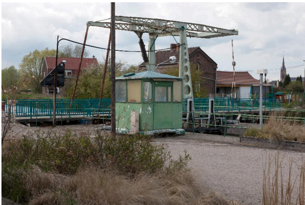
Vue générale de l'écluse de Warlaing.
