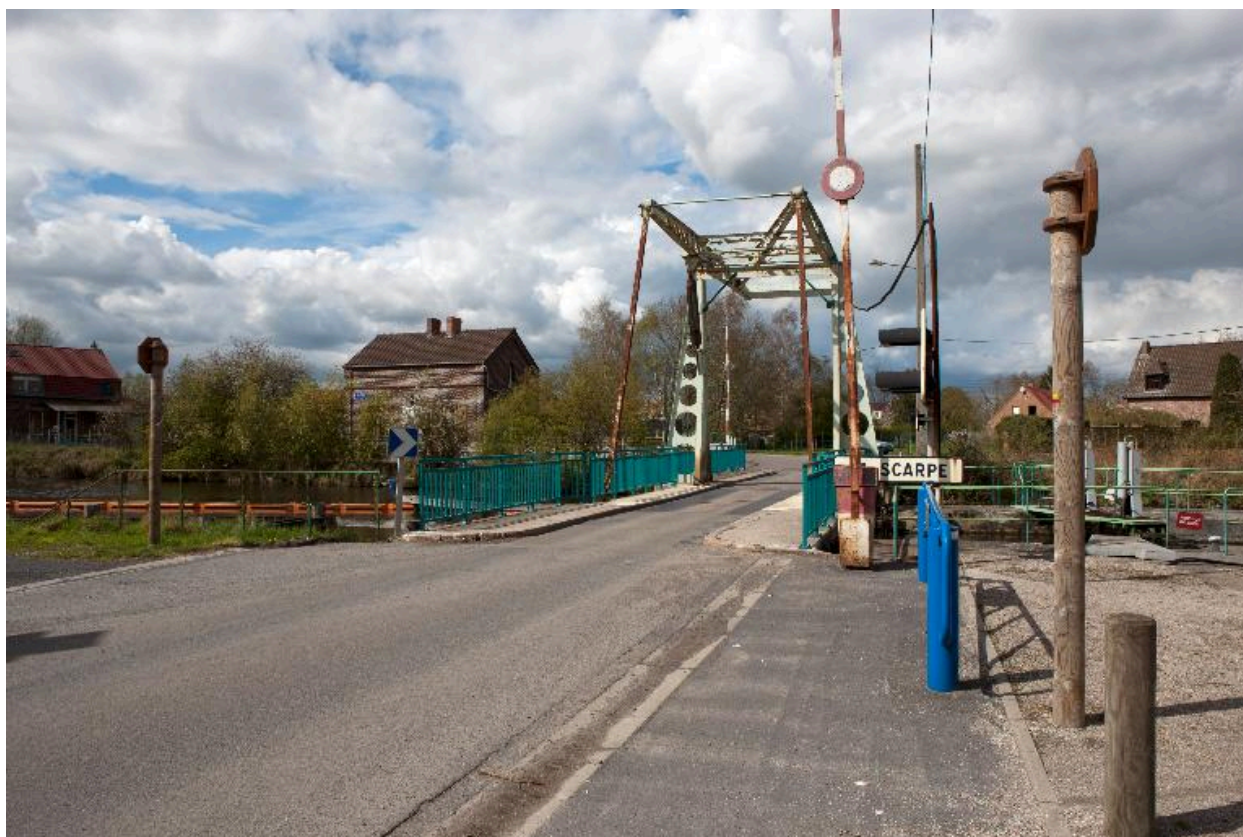
Le pont mobile sur la Scarpe.
