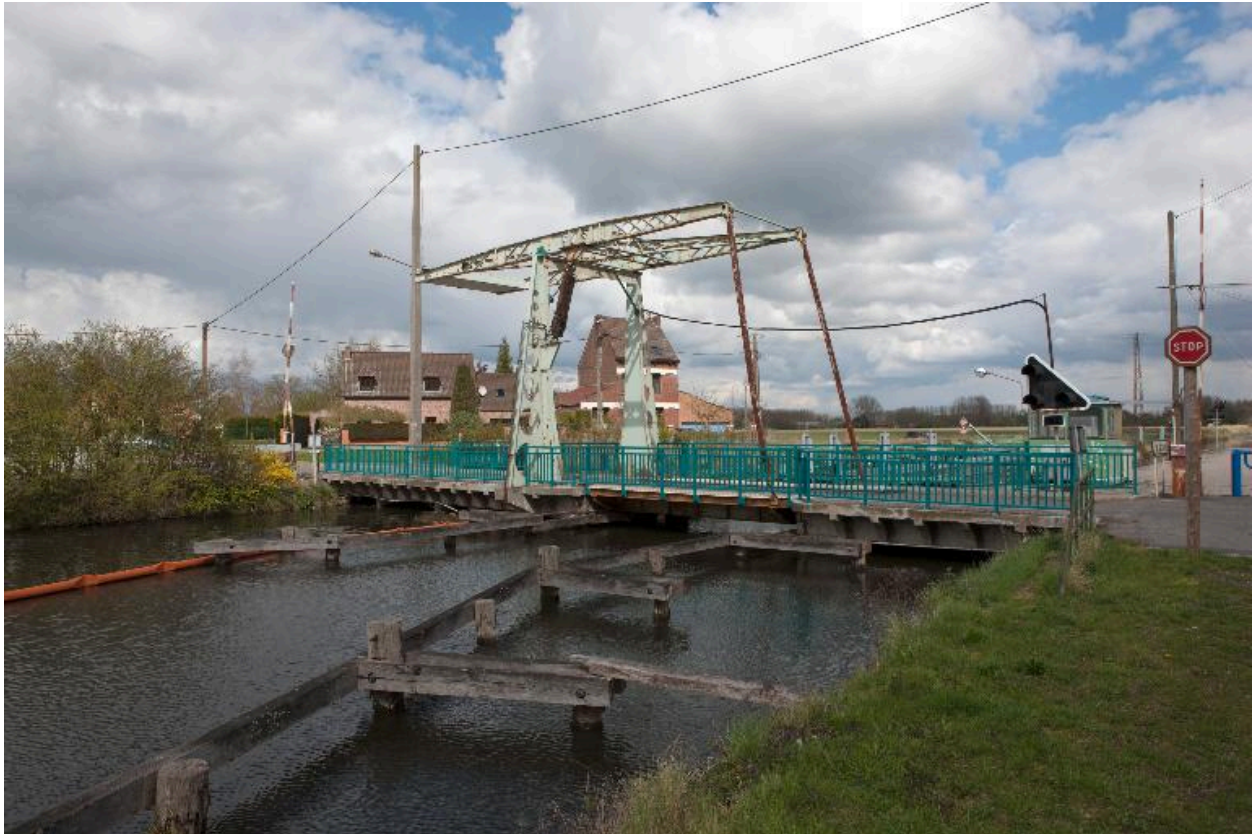
Le pont mobile sur la Scarpe.
