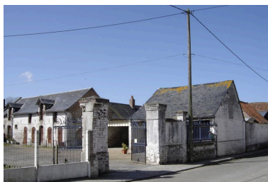
Vue du portail d'entrée. Phot. Inès Guérin IVR22_20058005504NUCA
