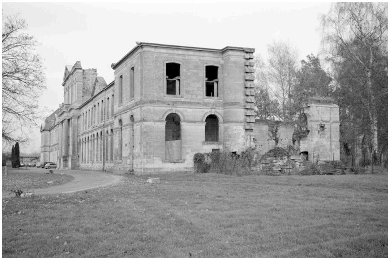
Vue d'ensemble sud des vestiges des bâtiments abbatiaux ayant servi de filature.
