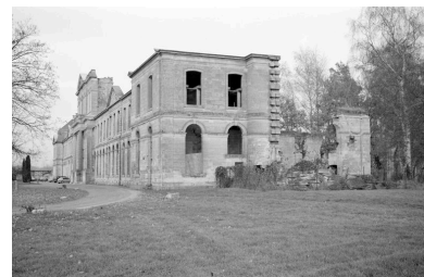
Vue d'ensemble sud des vestiges des bâtiments abbatiaux ayant servi de filature. Phot. Bertrand Fournier IVR22_19996001570Z
