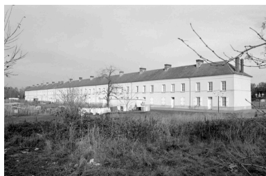
Logements ouvriers. Phot. Bertrand Fournier IVR22_19996001572Z
