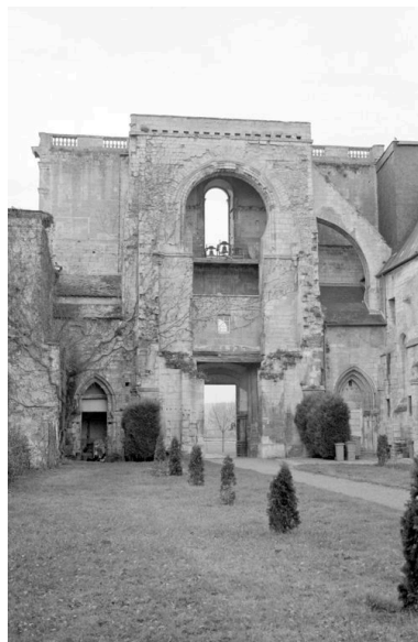
Revers de la façade de l'ancienne église abbatiale. Phot. Bertrand Fournier IVR22_19996001568Z
