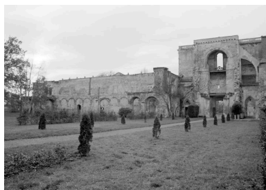
Revers de l'aile ayant abrité l'ancien grand tissage de coton et de la façade occidentale de l'église abbatiale. Phot. Bertrand Fournier IVR22_19996001567Z
