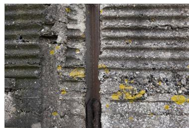
Elévation nord, détail de traces de coffrage
