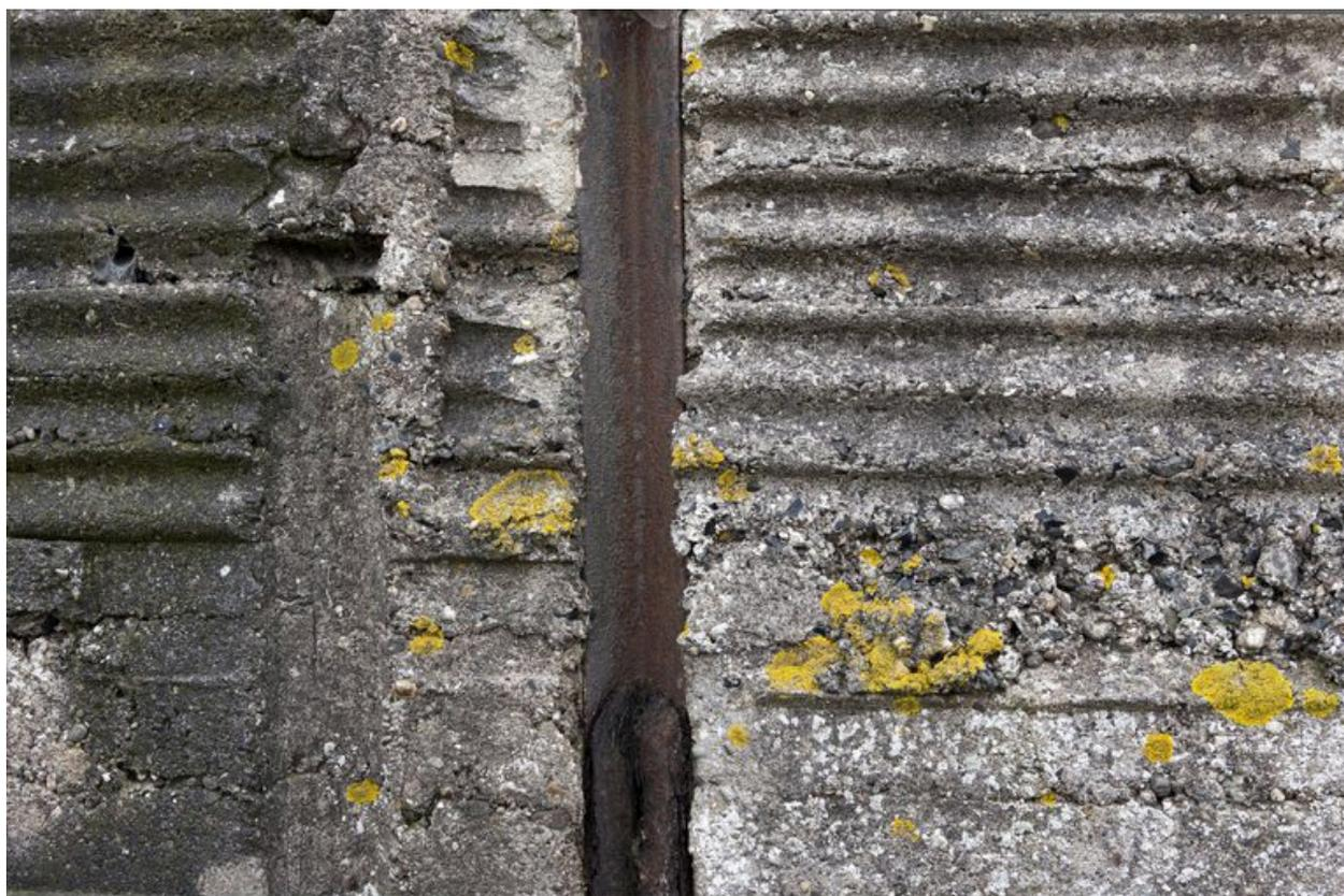
Elévation nord, détail de traces de coffrage
