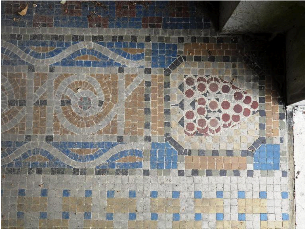
Vue de détail du pavement de sol.
