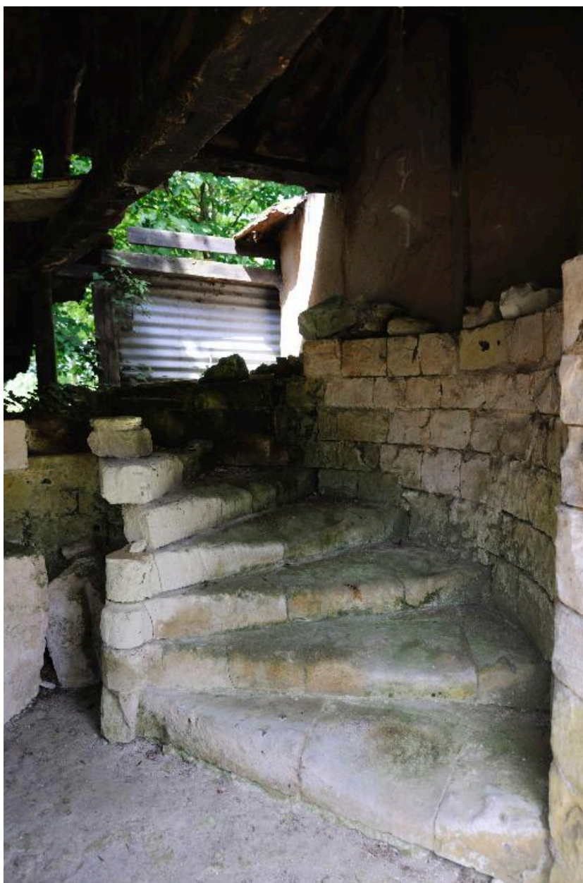
Escalier en vis d'un ancien bâtiment au sud du cloître.
