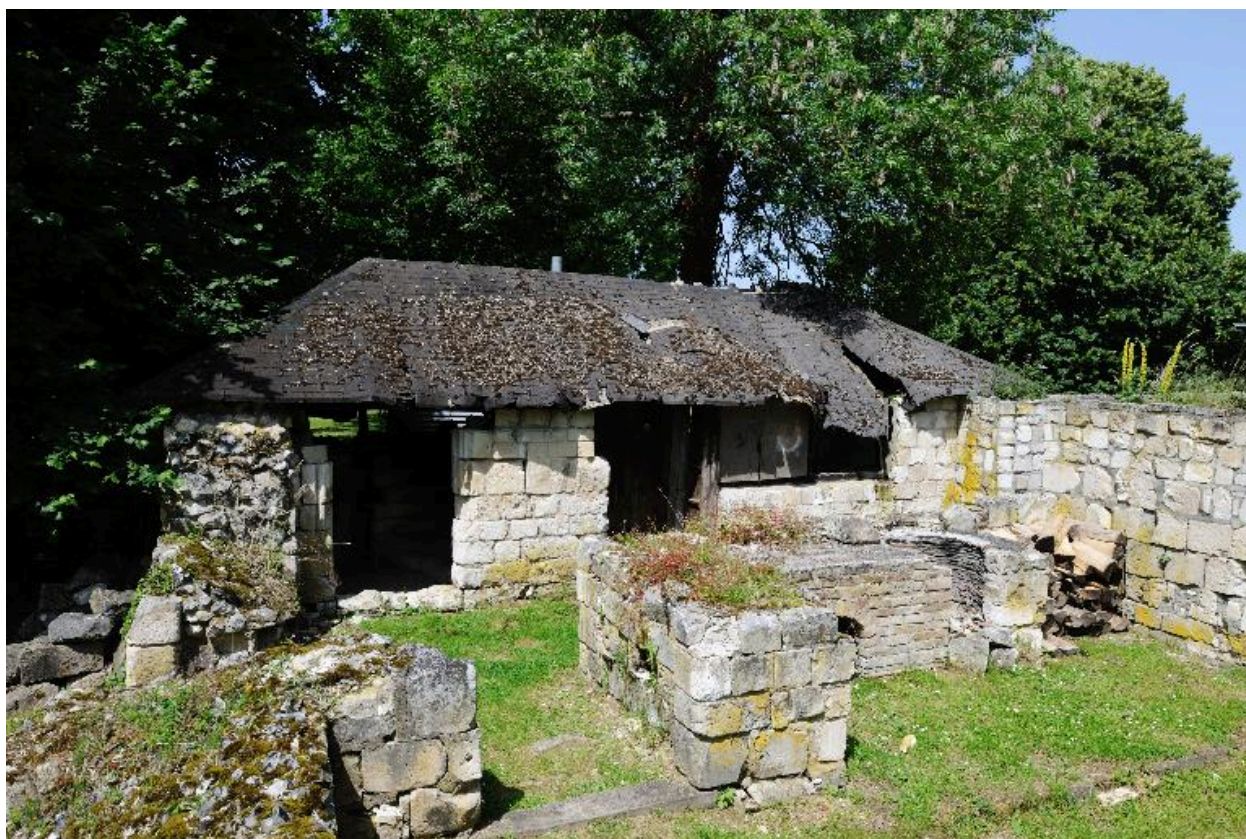
Ancien bâtiment au sud du cloître.
