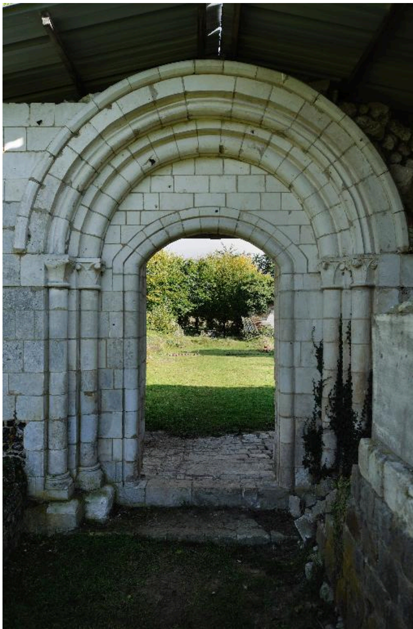
Portail occidental reconstitué de l'ancienne église priorale.
