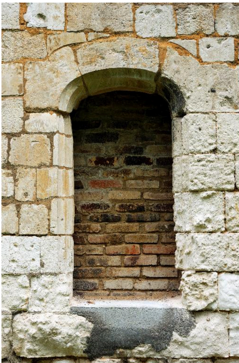
Baie murée d'un bâtiment prioral.
