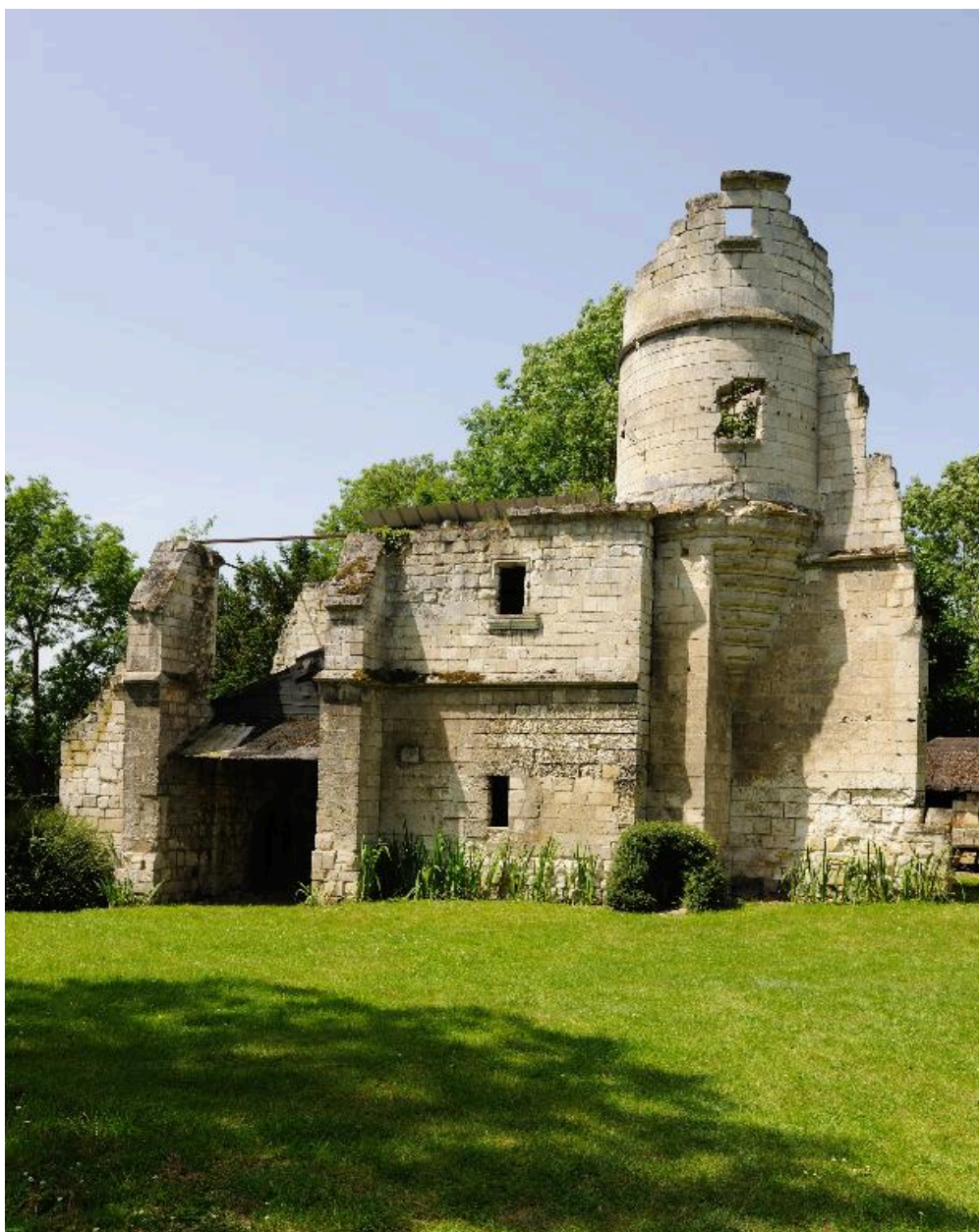
Porterie, vue extérieure depuis l'est.
