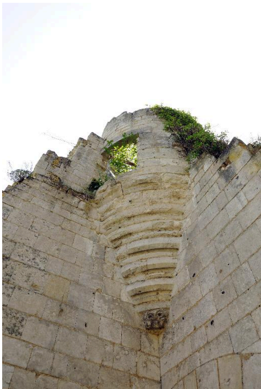
Echauguette de la tourelle de la porterie.
