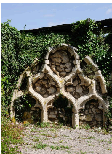
Eléments de baie flamboyante à remplage remontés dans le trésor. Phot. Marie-Laure Monnehay-Vulliet IVR22_20128001099NUC2A
