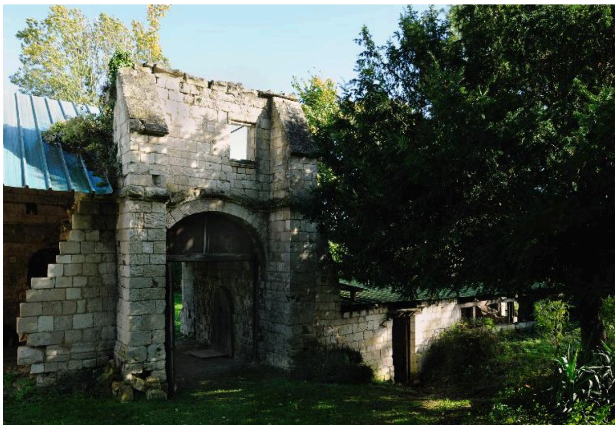
Porterie et ancienne infirmerie, vue intérieure.
