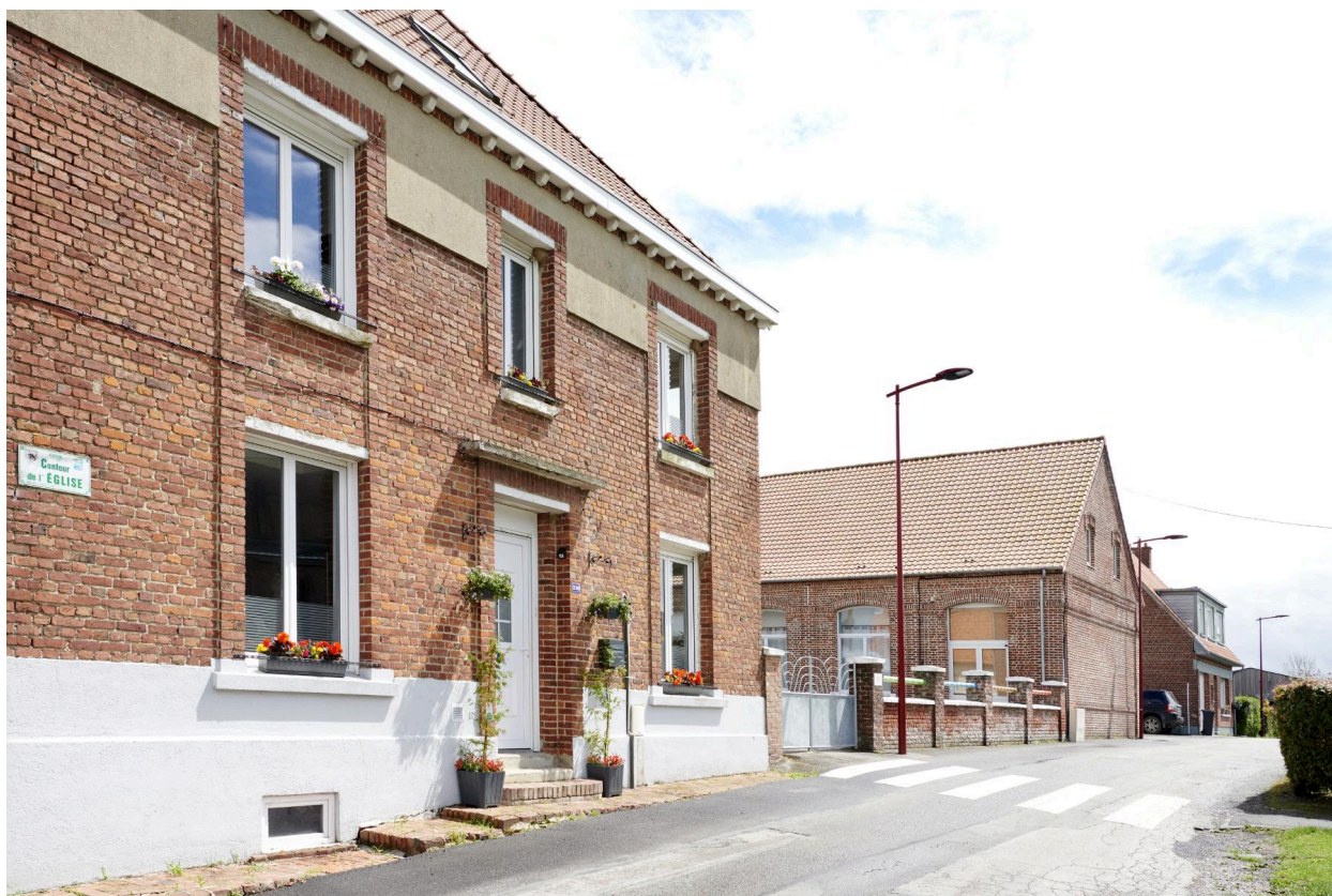
Ancien logement de l'instituteur à gauche, classe à droite.
