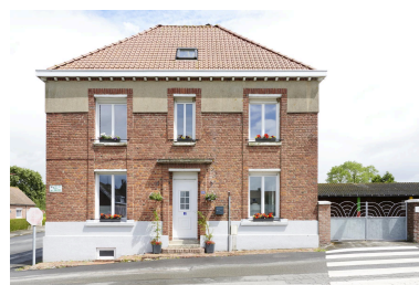
Façade principale de l'ancien logement de l'instituteur. Phot. Delphine Volto Jourdan IVR32_20245902700NUCA
