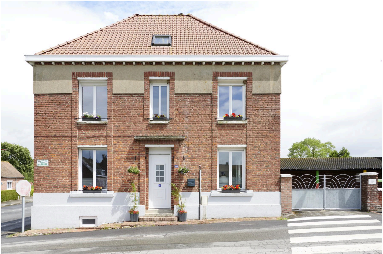
Façade principale de l'ancien logement de l'instituteur.
