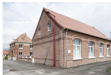
Bâtiment recevant la classe. Vue depuis la rue. Ancien logement de l'instituteur en arrière-plan. Phot. Delphine Volto Jourdan IVR32_20245902699NUCA
