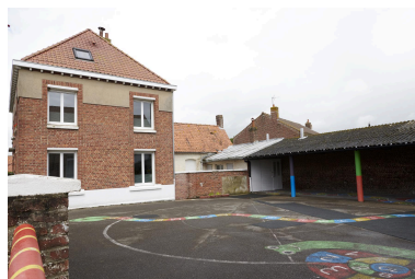
Ancien logement de l'instituteur, façade sur cour. Phot. Delphine Volto Jourdan IVR32_20245902698NUCA
