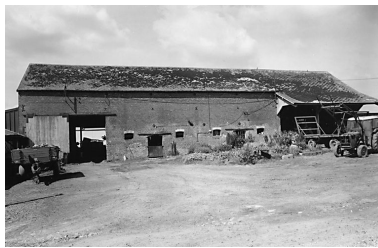
Grange-étable. Phot. Laurent Jumel IVR22_19980202882X
