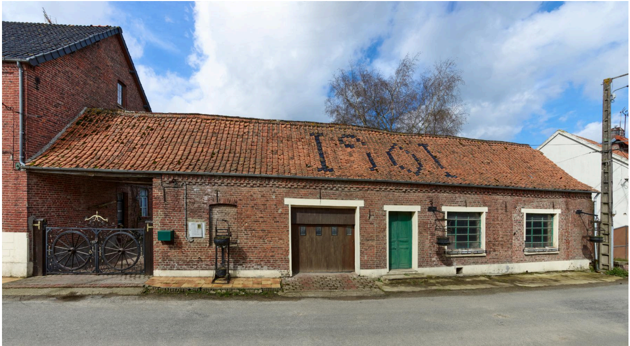
Vue de l'atelier depuis l'est.
