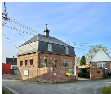
Vue d'ensemble de la mairie prise depuis le nord-est. Phot. Thierry Lefébure IVR32_20248000174NUCA
