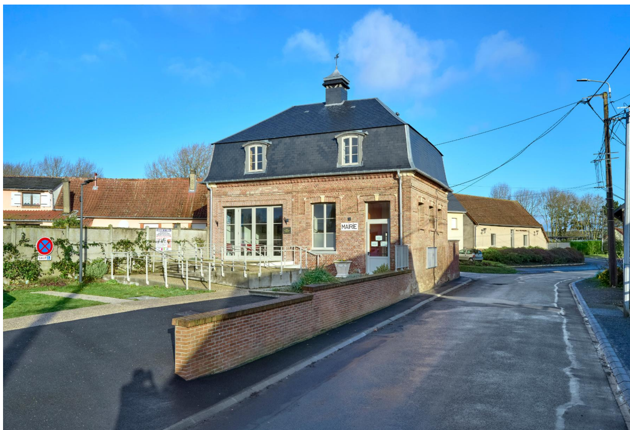
Façade sud de la mairie.
