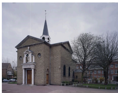
Vue générale. Phot. Philippe Dapvril IVR31_19945901017VA
