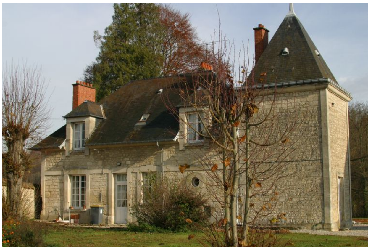
Vue du bâtiment en retour d'angle.
