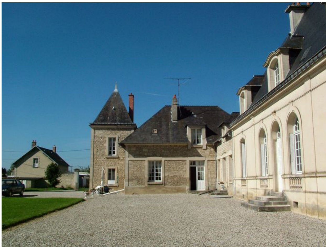
Vue antérieure de l'avant-corps gauche.
