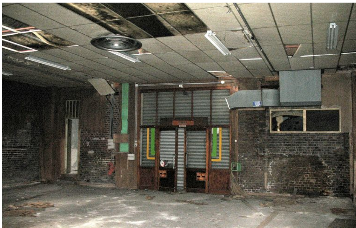
Mur pignon nord-est depuis l'intérieur.
