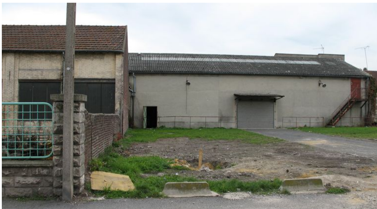
Façade nord-ouest remaniée.
