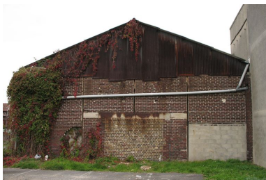
Etat du mur pignon sud-ouest en briques. Phot. Clarisse Lorieux IVR22_20066005160NUCA
