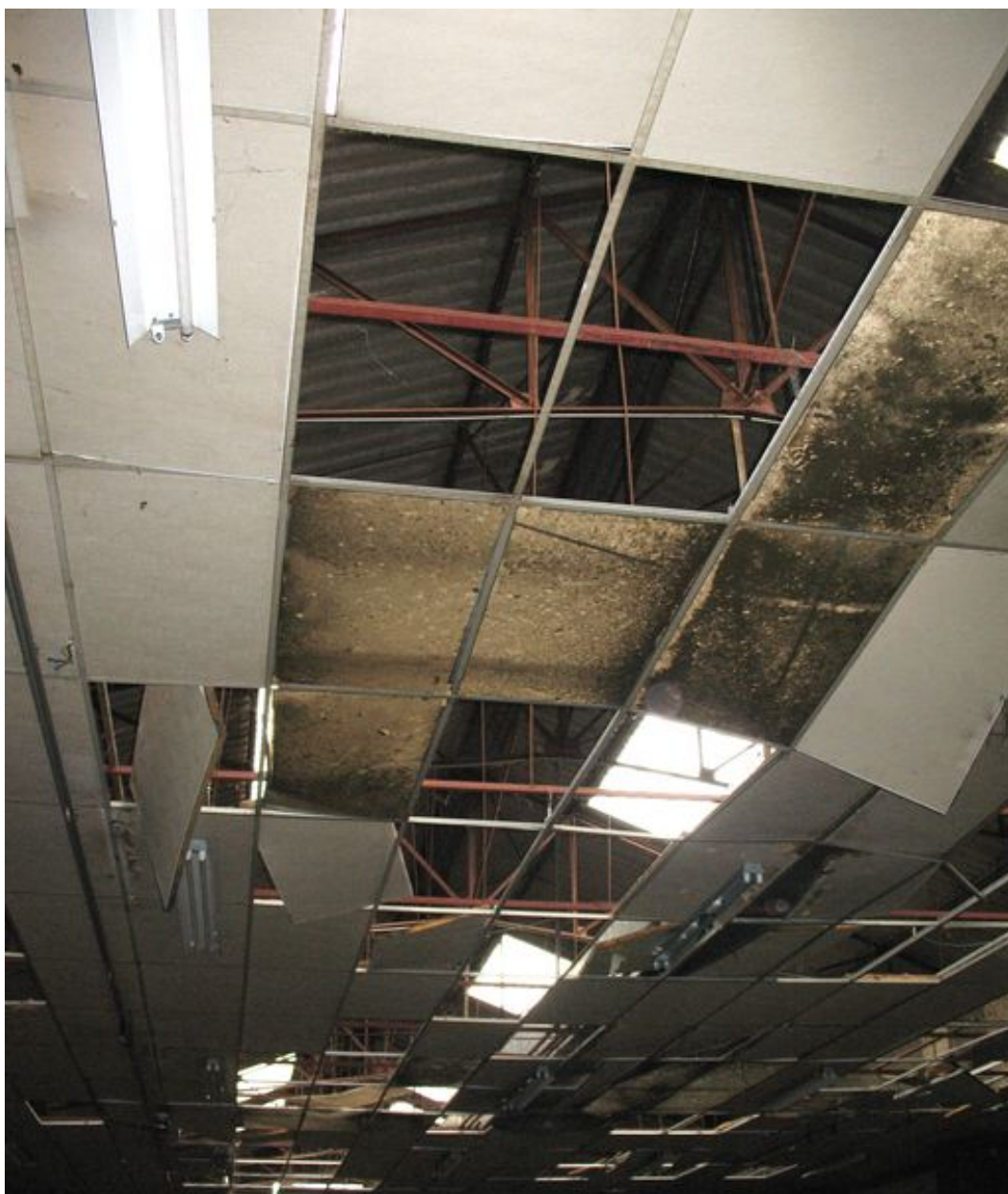
Le faux-plafond et la charpente métallique.
