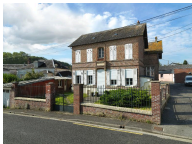
Ancien logement de l'instituteur. Phot. Thierry Lefébure IVR22_20148000512NUC2A
