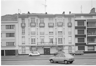
Façade sur voie. Phot. Philippe Caudroit IVR31_19816203489X
