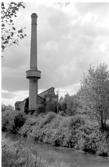
Cheminée d'usine, en 1988.
