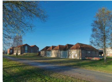
Anciens magasins de matériel. Phot. Thierry Lefébure IVR22_20128001175NUC2A
