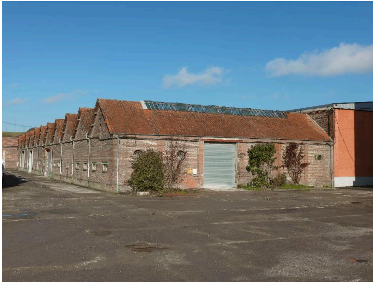
Bâtiment de l'ancienne filature.
