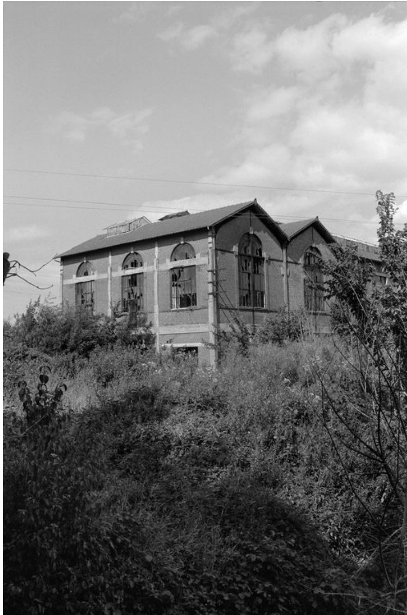
Centrale thermique, en 1988 : flanc ouest.
