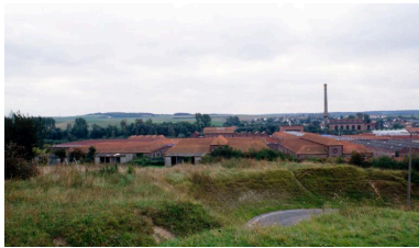
Vue d'ensemble du site industriel en 1993. Phot. Benoît Dufournier IVR22_19938000019ZA
