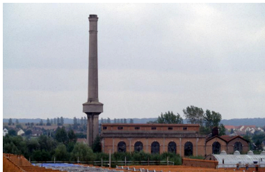
La chaufferie et la cheminée en 1993.
