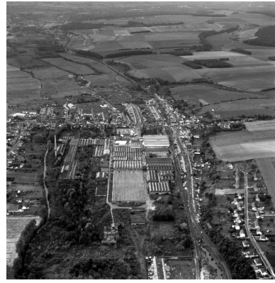
Vue aérienne, flanc est, en 1988. Phot. Phot'R IVR22_19888001522P
