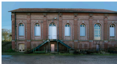
Façade nord de l'ancien bâtiment des batteries. Phot. Thierry Lefébure IVR22_20128001189NUC2AQ
