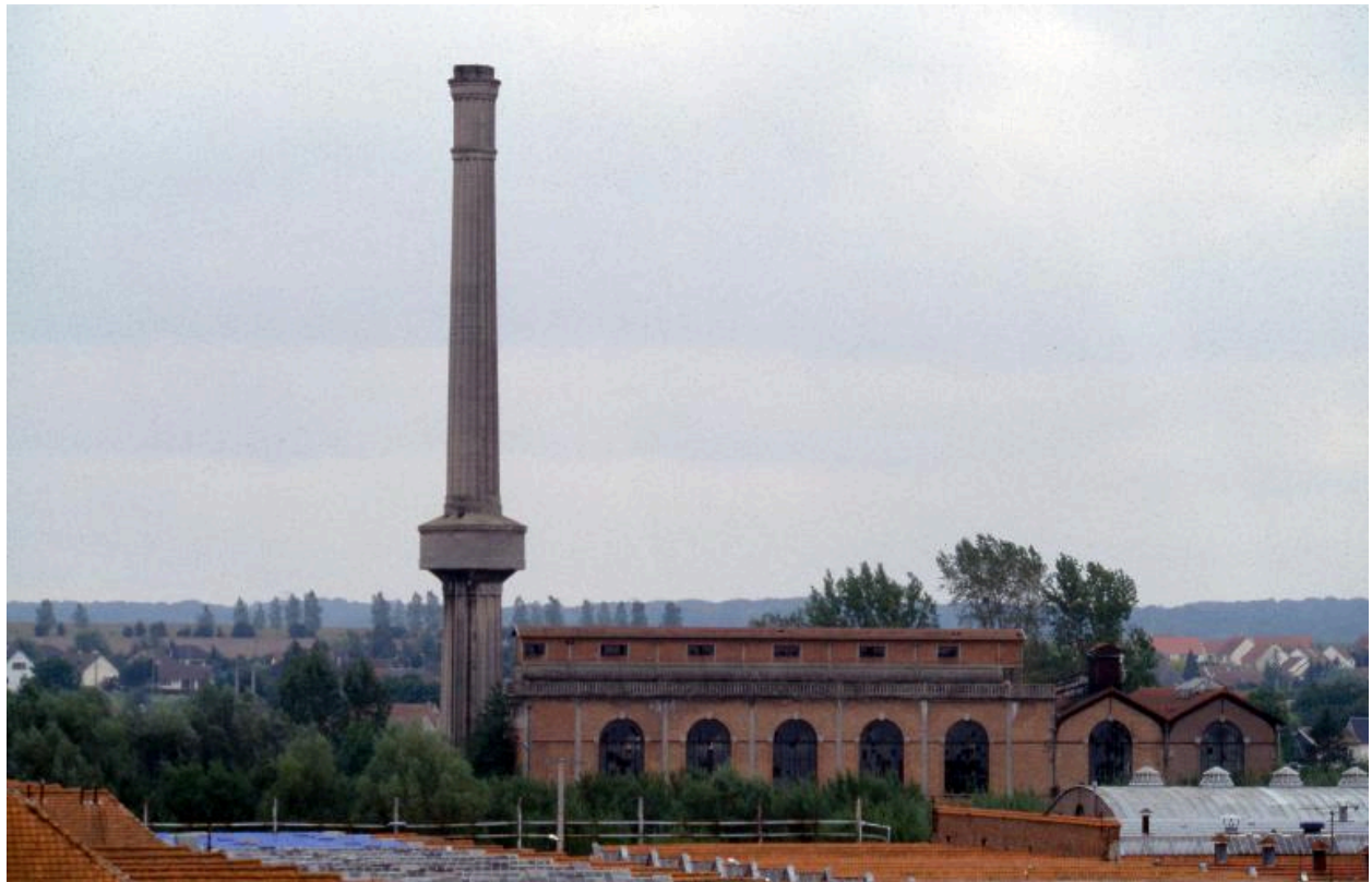
La chaufferie et la cheminée en 1993.
