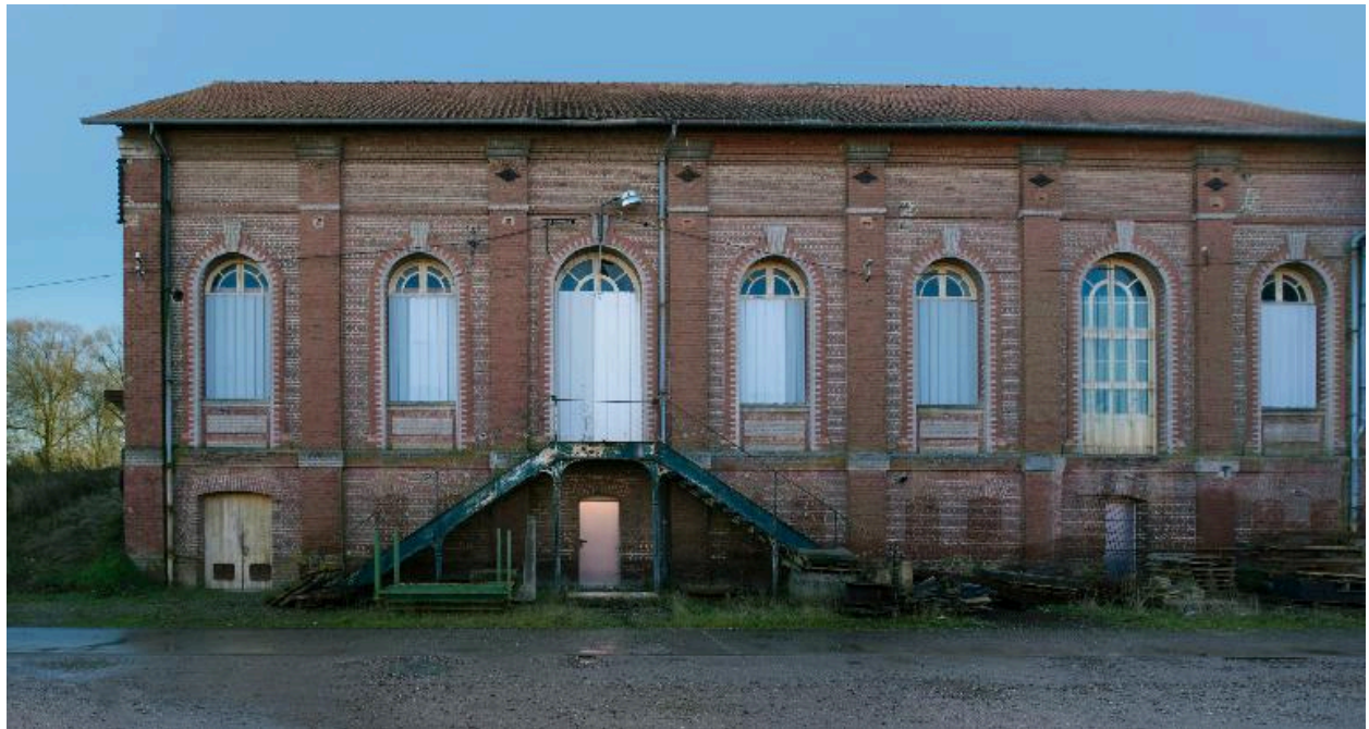
Façade nord de l'ancien bâtiment des batteries.
