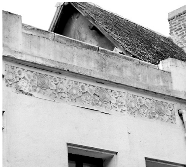
Façade du n° 12, détail : frise en ciment moulé située sous la corniche.
