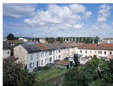
Vue générale de la cité des Faïenciers.
