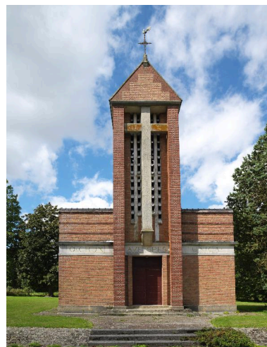
Vue de la façade principale. Phot. Marie-Laure Monnehay-Vulliet IVR22_20158000685NUC2A
