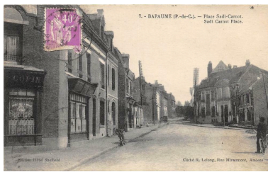
7 - bapaume, Pas de Calais - Place Sadi Carnot - Sadi Carnot place. Edition Hôtel Sheffield, cliché R. Lelong, rue Miraumont, Amiens. Carte postale, vers 1930 (coll. part.). Vue de la partie Est de la place depuis la rue de Péronne. Phot. Pierre Thibaut IVR32_20206200020NUCA
